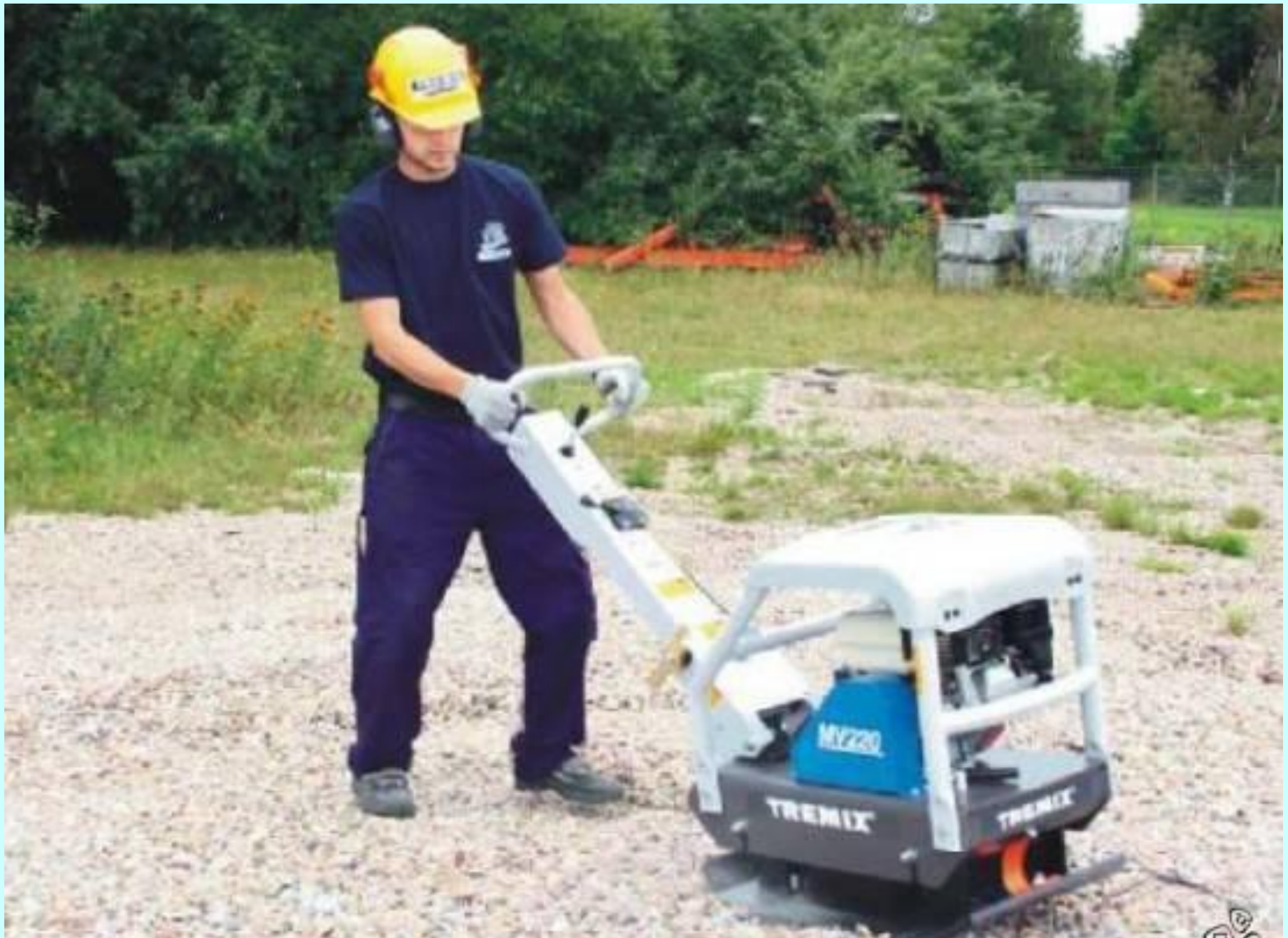
Уплотнение песчаного грунта
