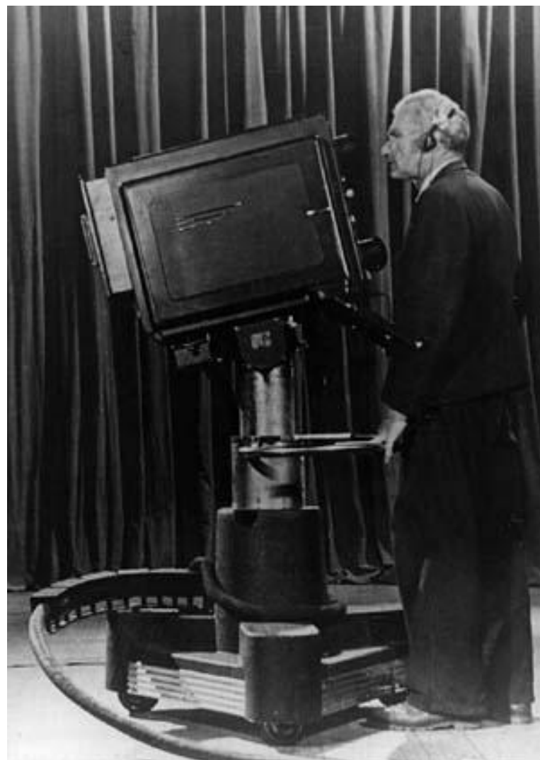
Телевизионная камера на иконоскопе. Архив НИИТ
