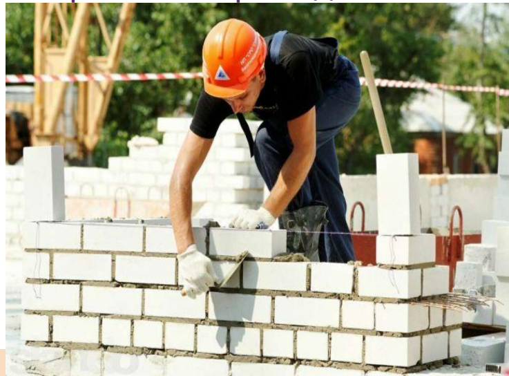
7. Строитель строит дом
