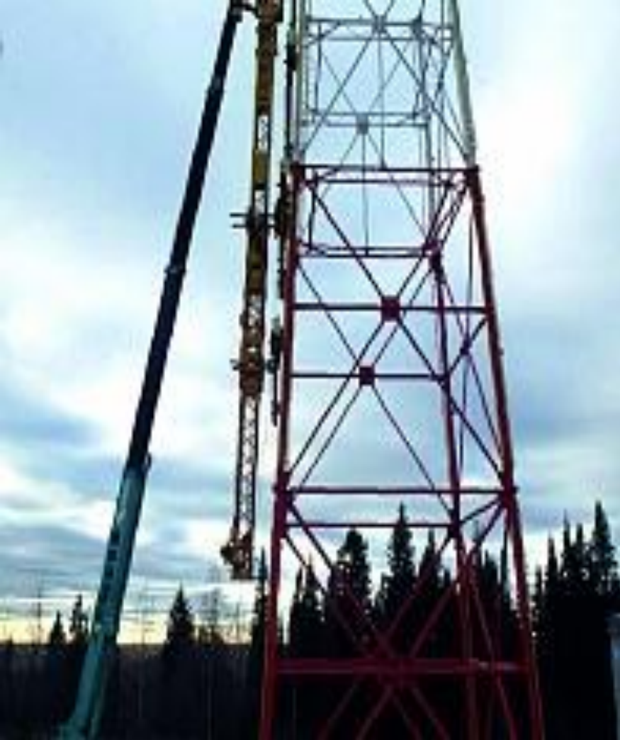
Установка ползущего крана на смонтированные конструкции сооружения самоходным краном
