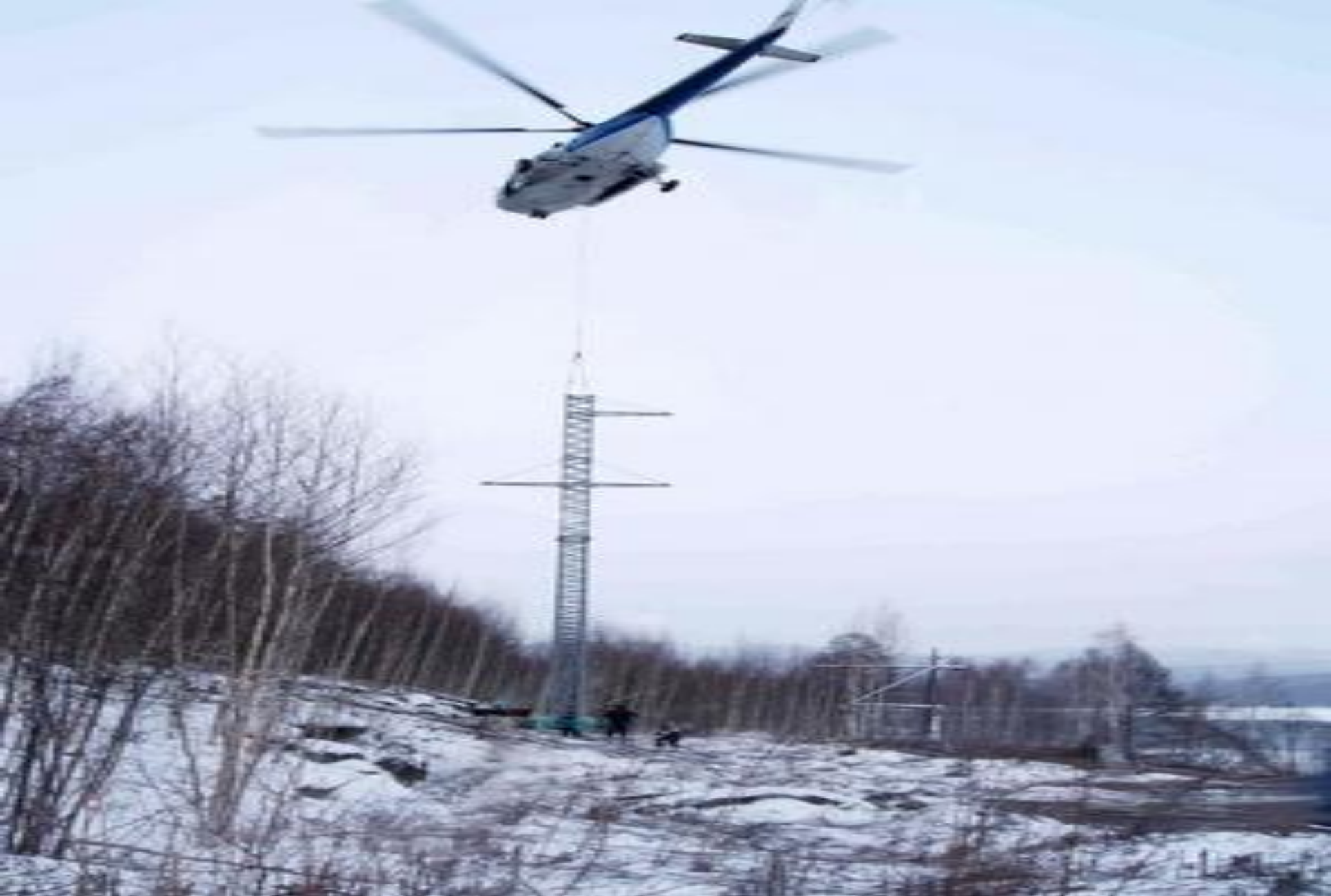
Монтаж сооружения вертолетом
