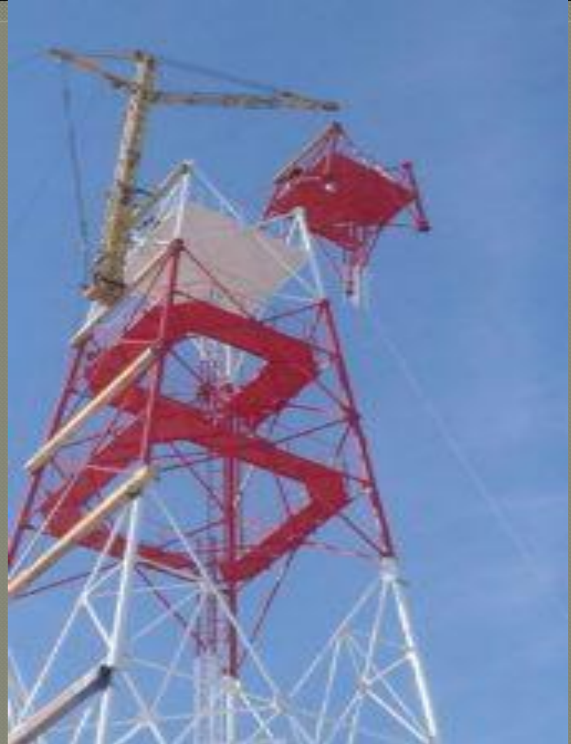
Монтаж секций сооружения ползущим краном
