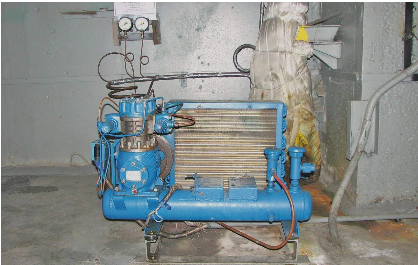
Рис. 5.4 Система осушения охлаждающего водорода
