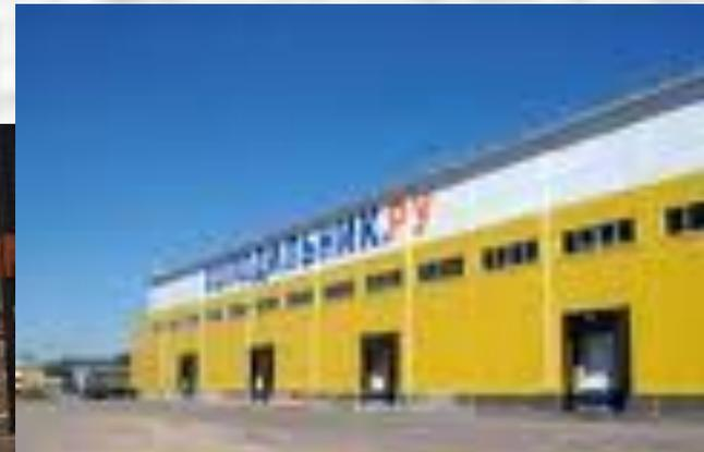
**В качестве теплоизоляции в холодильниках чаще всего используют пенополиуретановые панели, имеющие самую низкую теплопроводность, повышенную плотность и однородность по сравнению с другими утеплителями. Эти панели являются экологически чистыми. Они самонесущие.**
