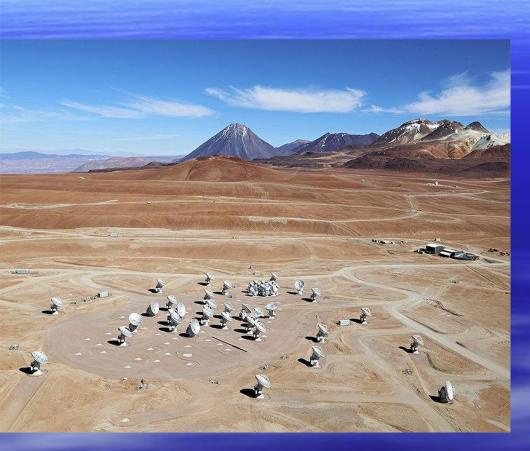
Обсерватория ALMA также находится в высокогорной пустыне Атакама, рядом с Очень Большим Телескопом и обсерваторией университета Токио. ALMA имеет 66 высокоточных радиотелескопов с диаметром 12 м, действующих как единый телескоп. Телескоп ALMA зондирует Вселенную на миллиметровых и субмиллиметровых частотах.
