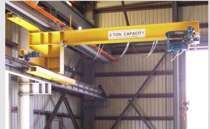
Неповоротный консольный настенный передвижной кран
