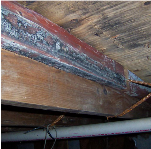
Фрагменты конструкций покрытия с биопоражением
