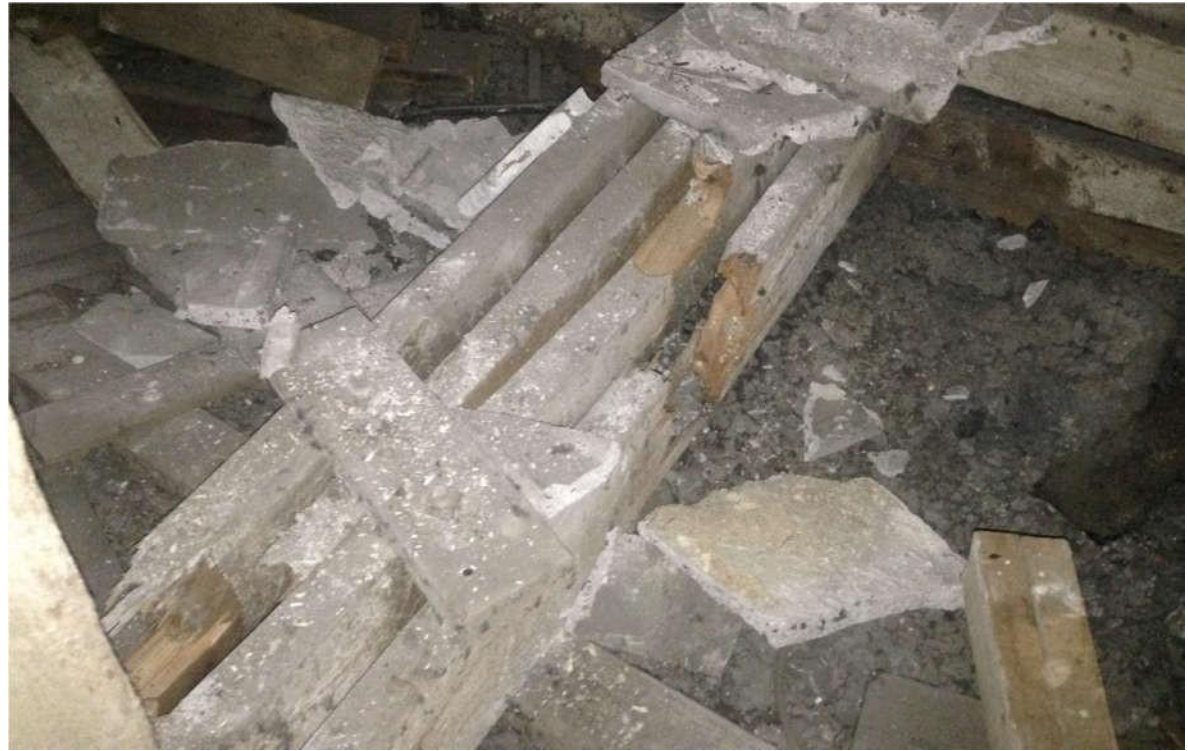
Разрыв нижнего пояса сегментной фермы
