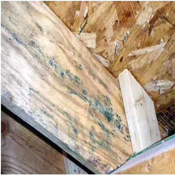
Фрагменты конструкций покрытия с биопоражением
