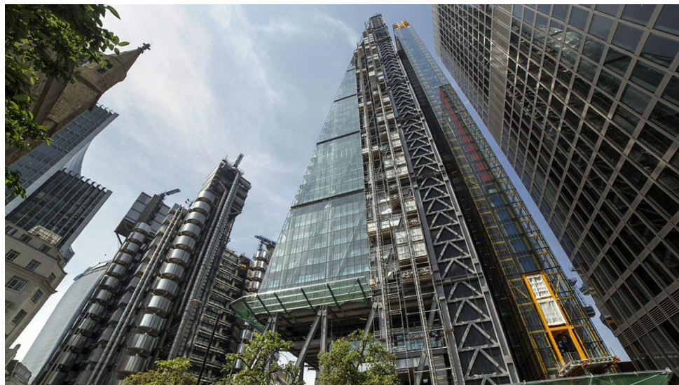
Здание на Лиденхолл стрит, арх. Р. Роджерс
