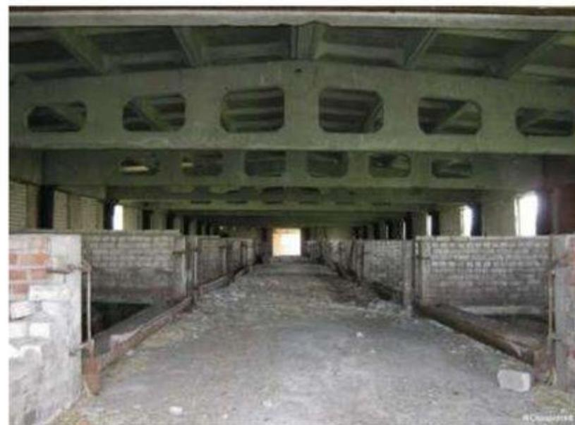
Железобетонная балка с решетчатой стенкой
