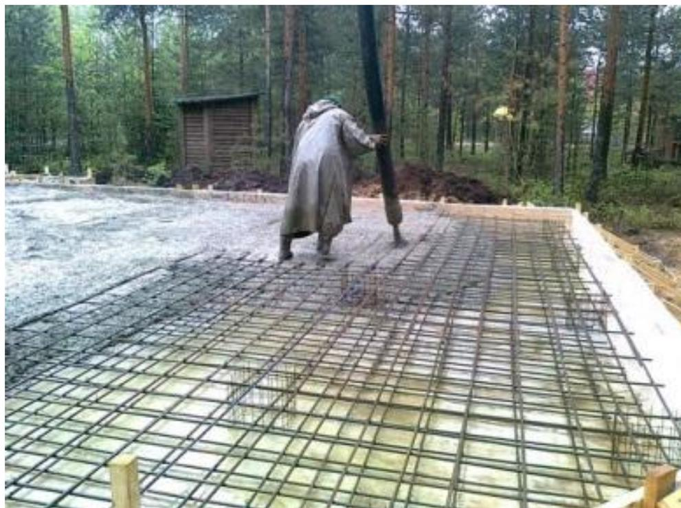
Готовую заливку «прогладьте» лопатой по всей поверхности. Делайте это плавно и осторожно. Так вы удалите лишний воздух и окончательно заполните даже мельчайшие полости.
