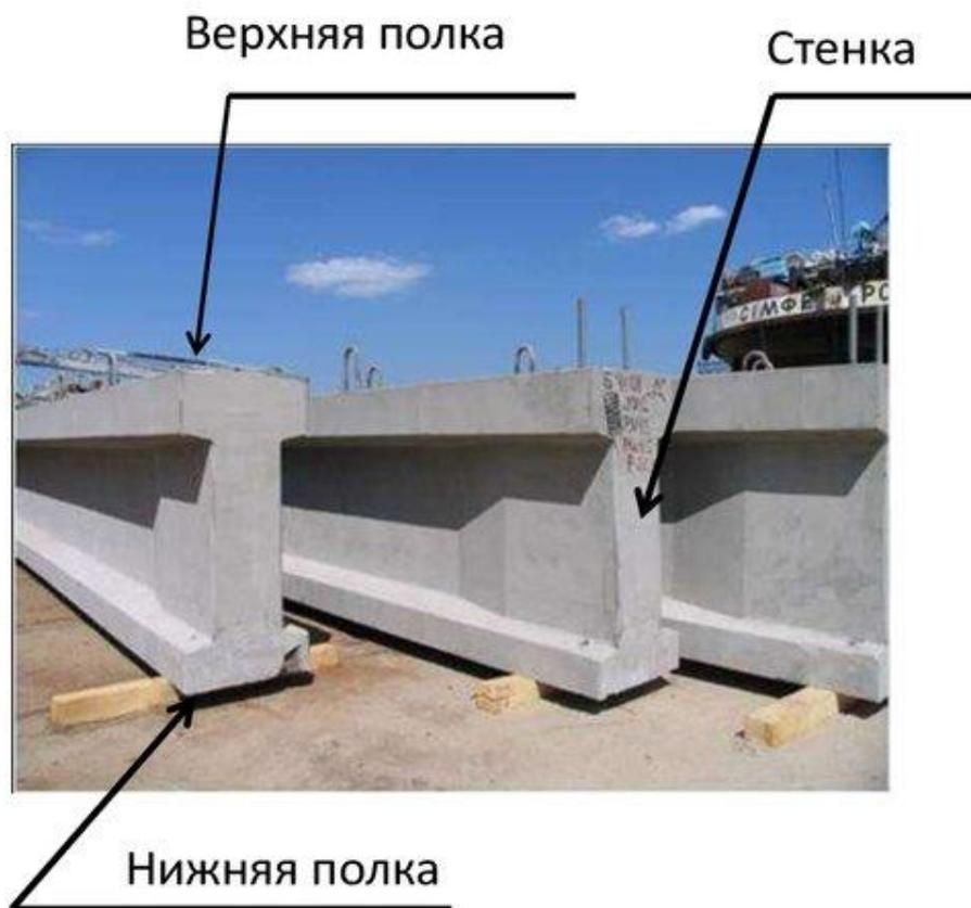
Железобетонная балка с параллельными поясами двутаврового сечения
