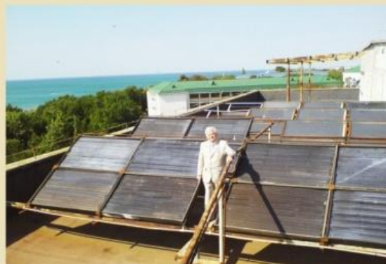
Солнечная котельная, Николаевка, пансионат «Полимер»,50м 2 . 5 куб.м. горячей воды в день. Работает с 2002 г.
