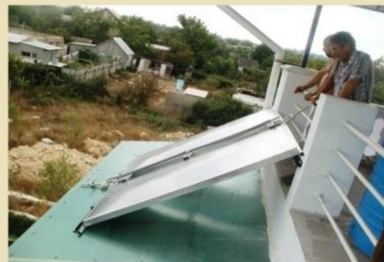
Гелиоустановка, частный дом, Севастополь, Сапун-гора, 4м 2 . 300 л. горячей воды в день.
