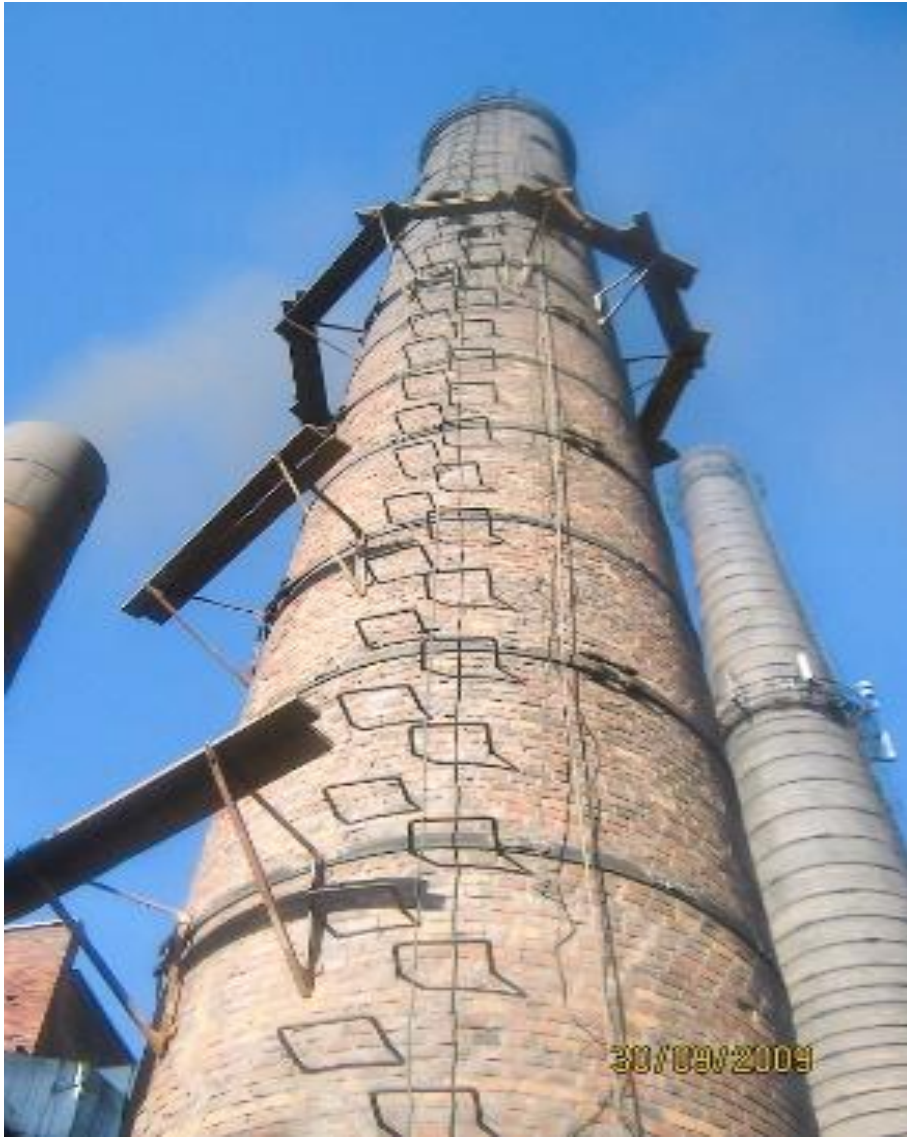
Ремонт дымовой трубы (H=82м)
