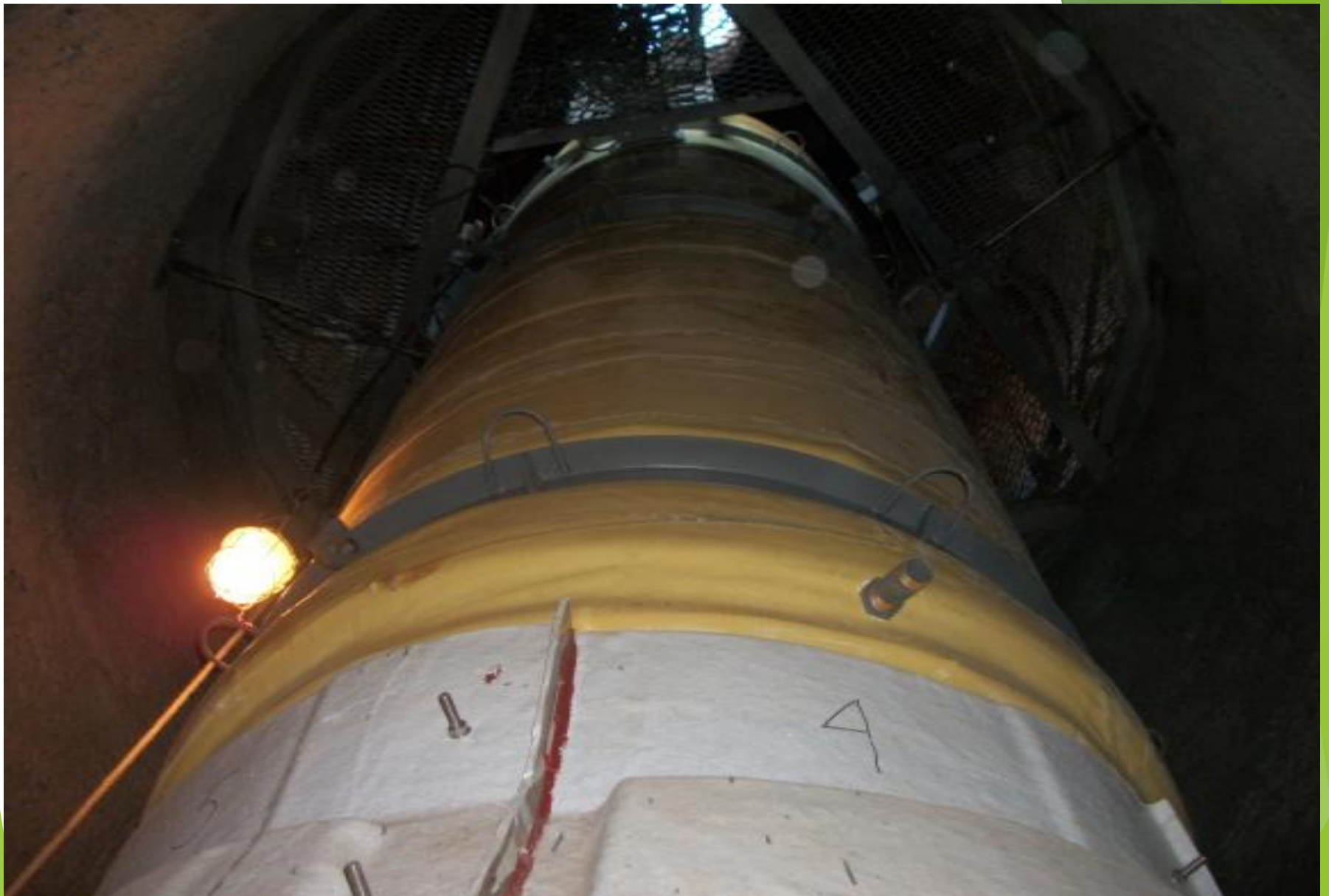
Ремонт стеклопластиковых футеровок дымовых труб
