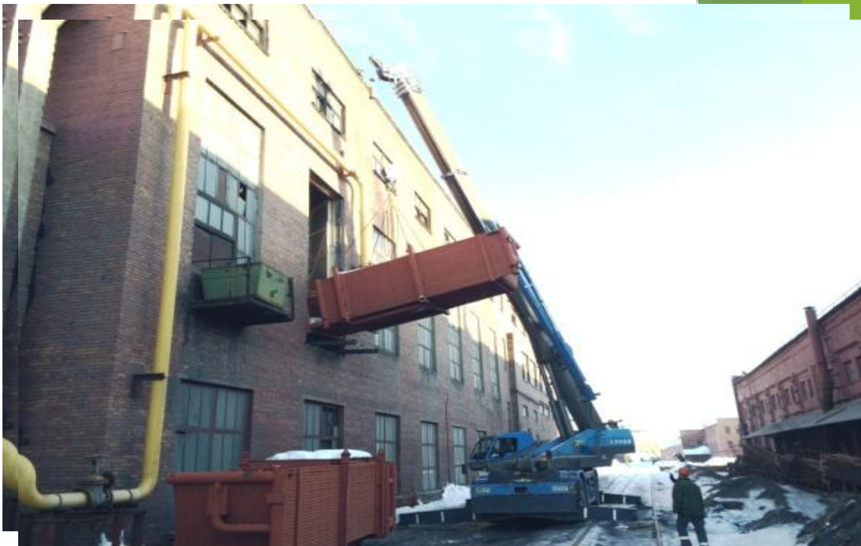
Монтаж водогрейного котла (75т.) через боковой проем
