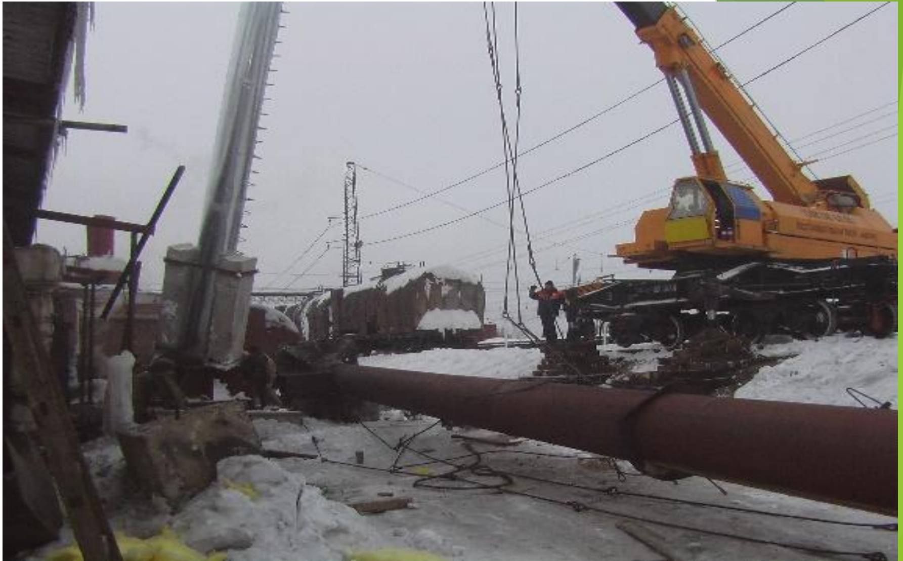
Монтаж дымовой трубы
