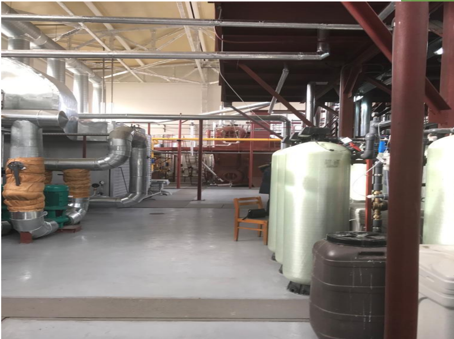
Строительство котельных «под ключ» Котельная завода Химфарм
