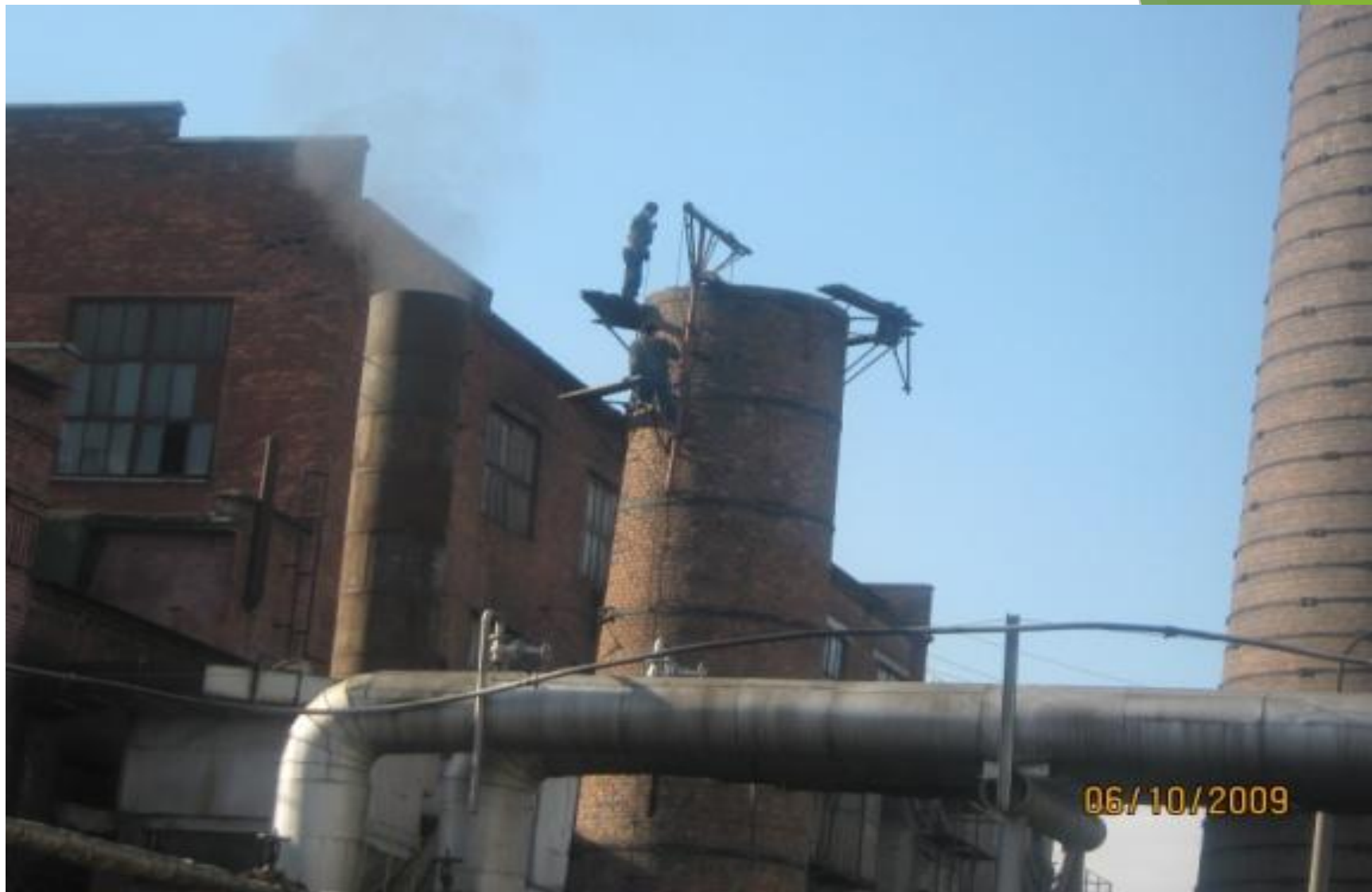
Перекладка кирпичной дымовой трубы (H=26м)
