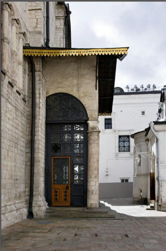
Портик западного входа в Успенский собор. Вид с юга.
