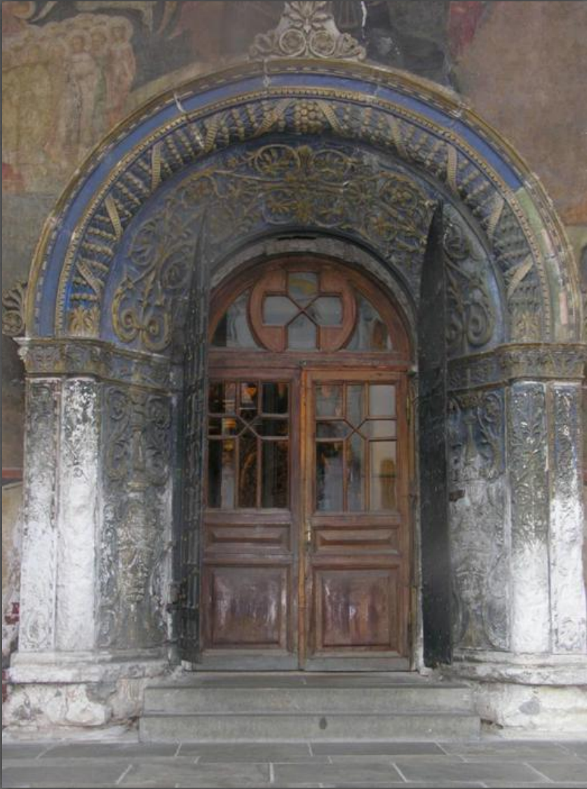
Центральный портал западного фасада Архангельского собора.
