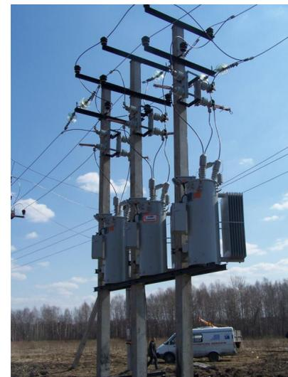
Напряжение вторичной обмотки  $\Delta U$  трансформатора ПТ суммируется с напряжением линии  $U_{Л1}$  и изменяет его до значения
