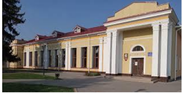
Основна будівля ДЮСШ (м. Бердичів, вул. Європейська, 35/1)
