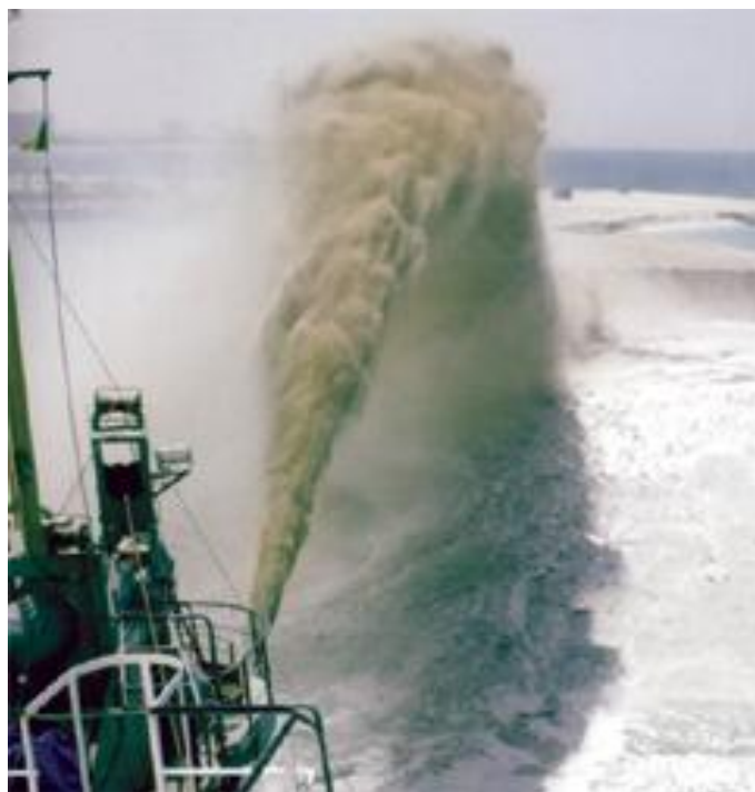
Намыв грунта в С-Петербурге. на Васильевском острове
