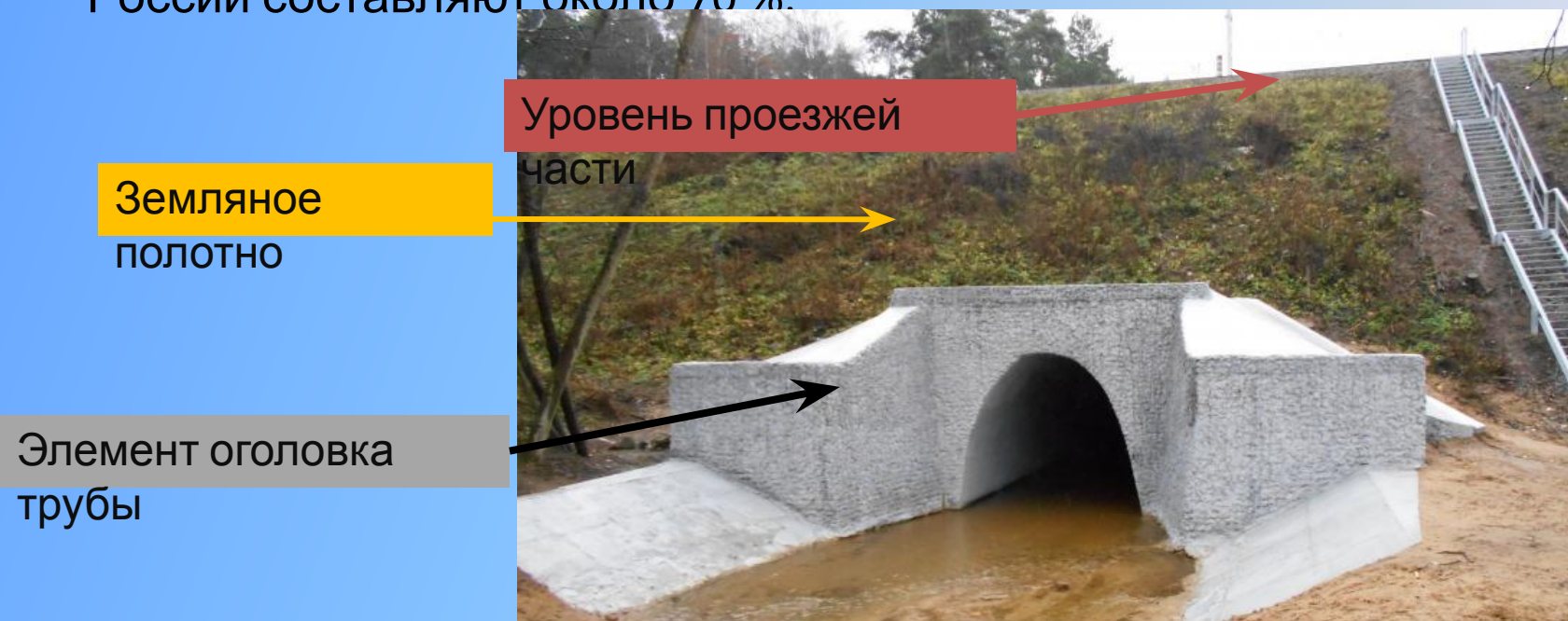
Схема расположения трубы в теле земляного полотна дороги
