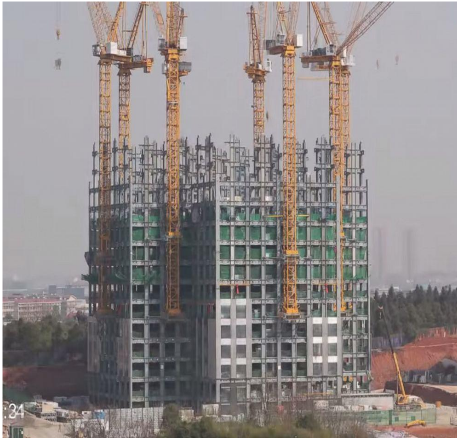
6 самоподъёмных ползущих кранов
