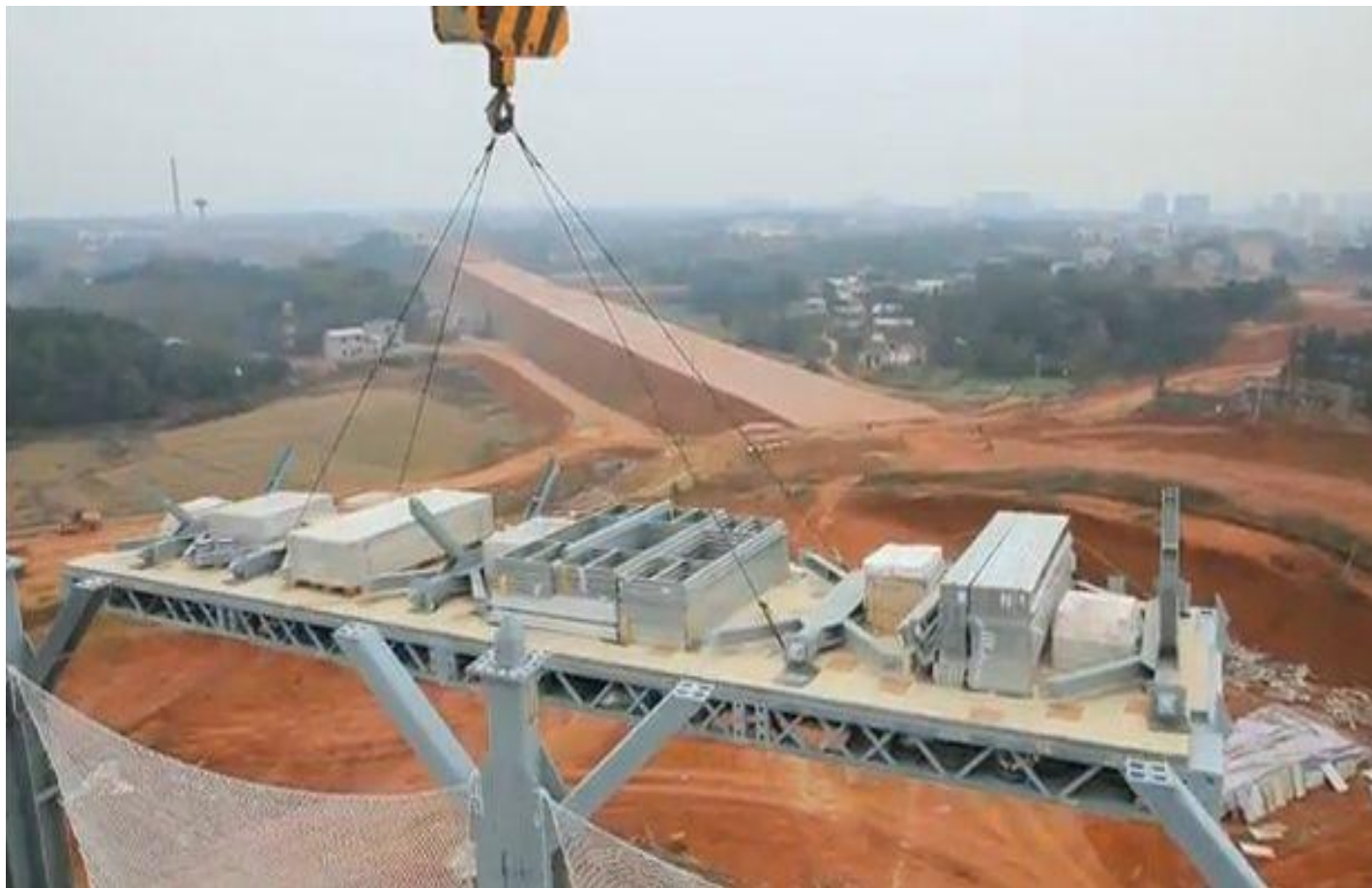
Подъем плиты перекрытия
