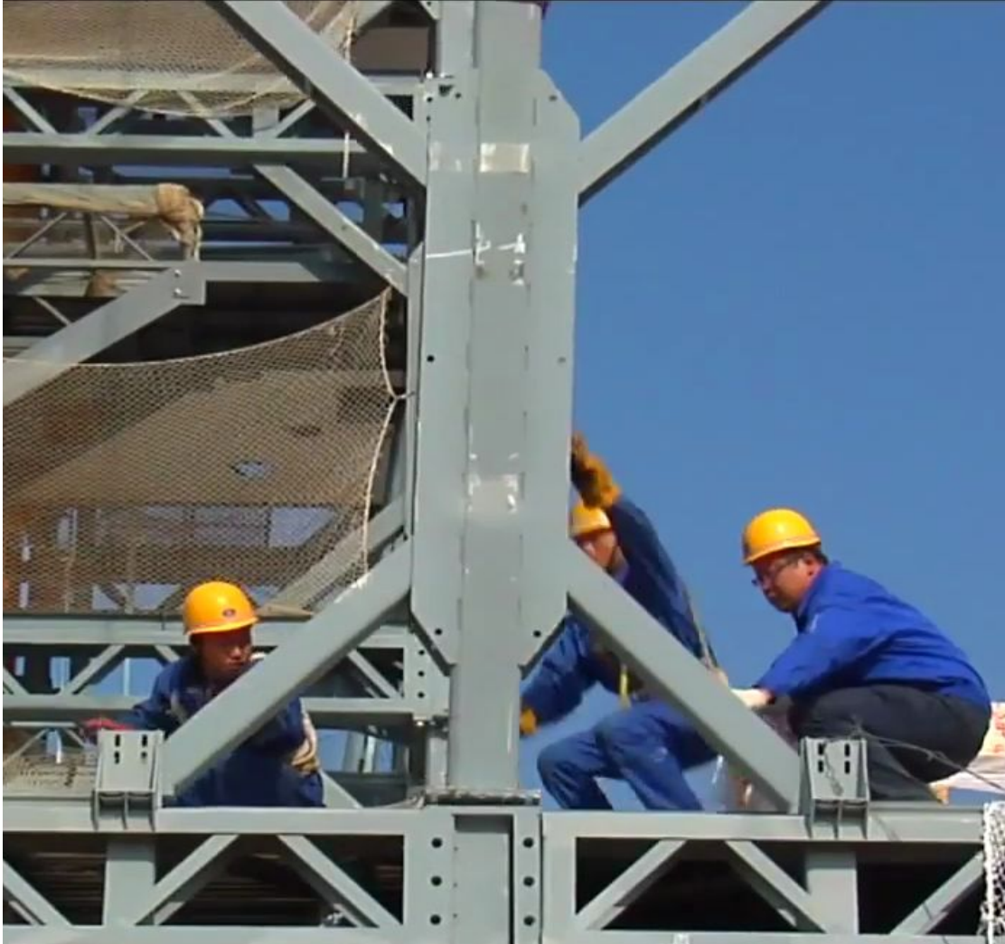
Монтаж колонны в муфту нижележащей плиты перекрытия
