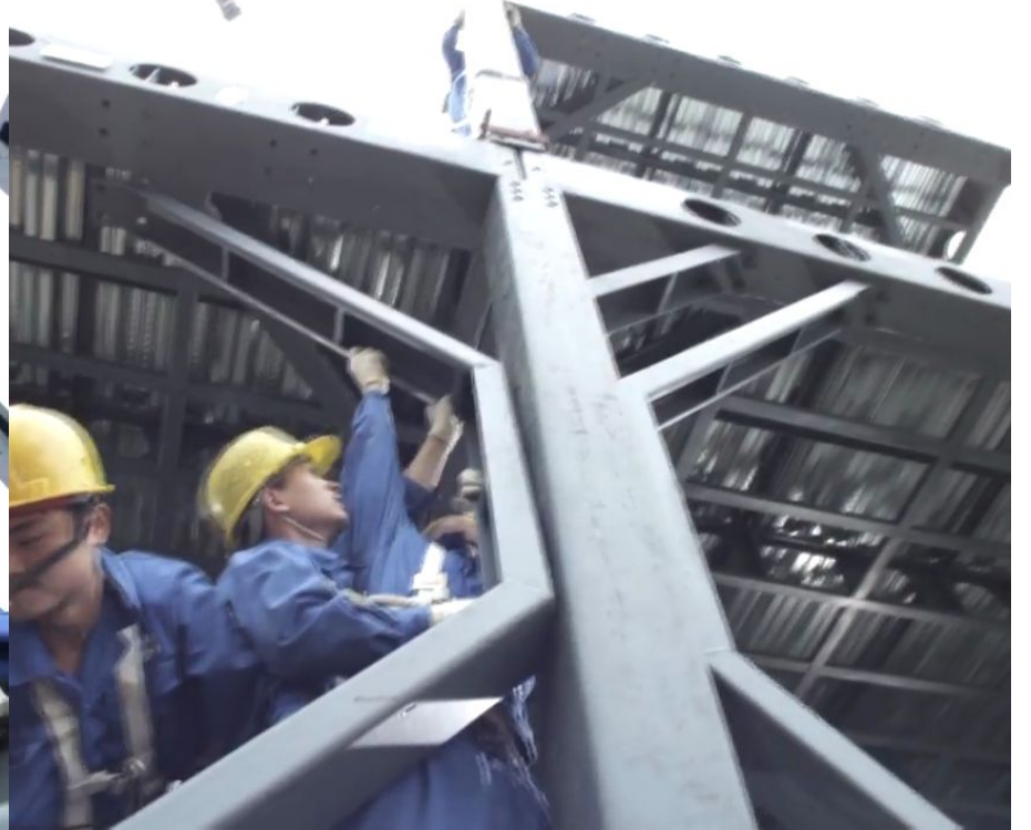
Монтаж раскосов колонны
