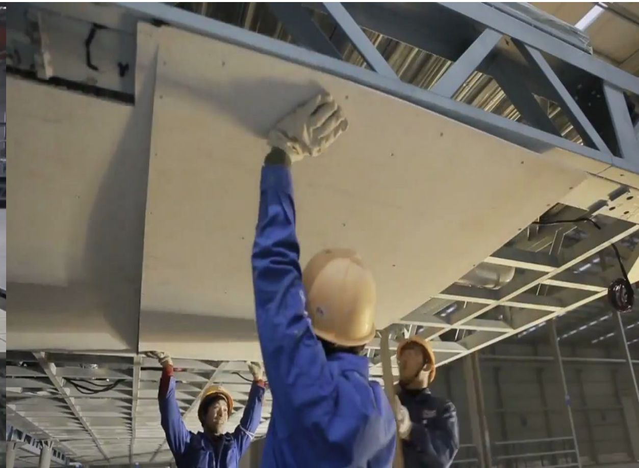
Монтаж потолочного покрытия
