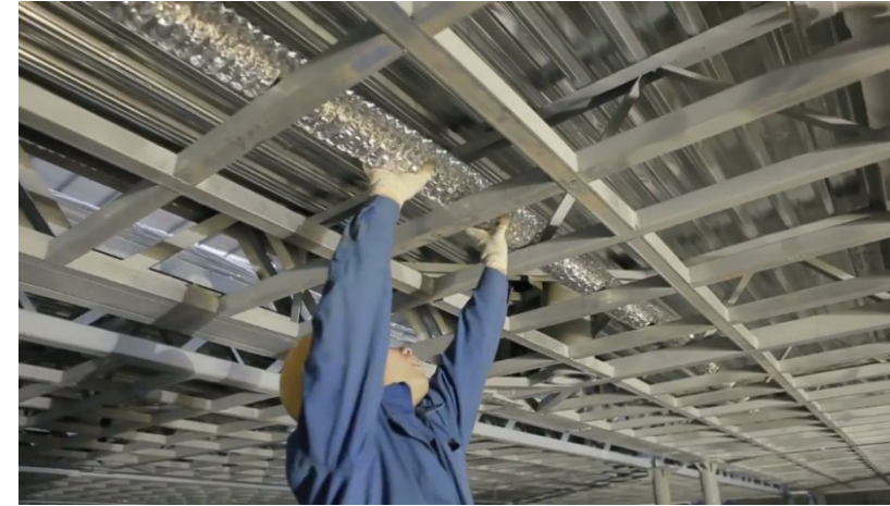
Монтаж вентиляционного канала
