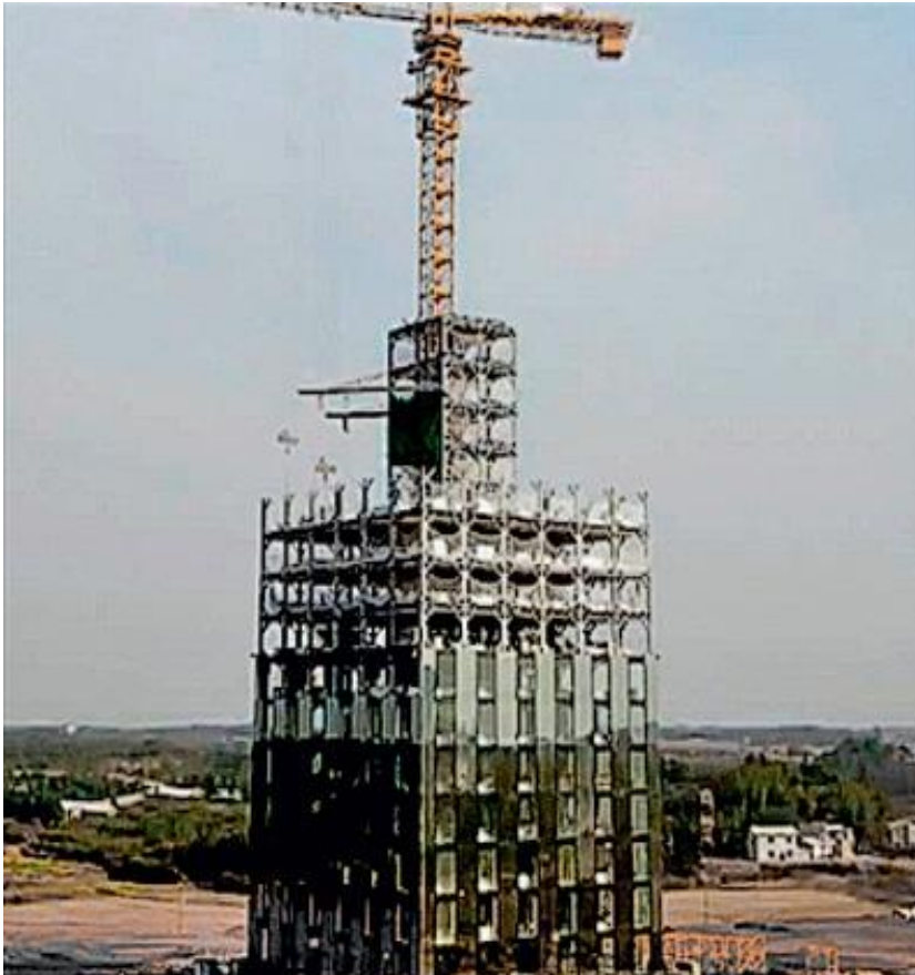
Грузоподъемные механизмы: самоподъемный кран, монтажная стрела
