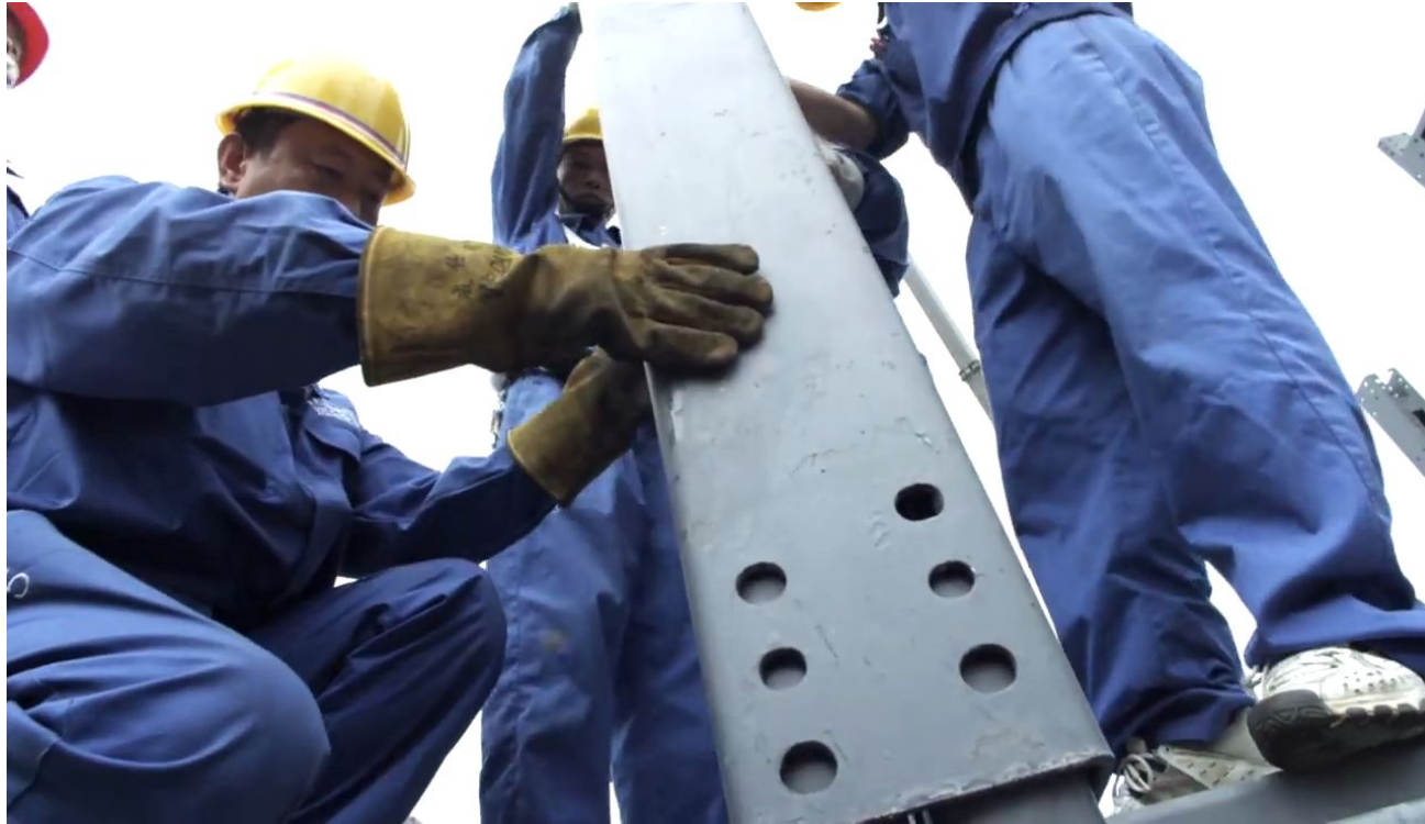
Монтаж колонны на втулки нижележащей плиты перекрытия
