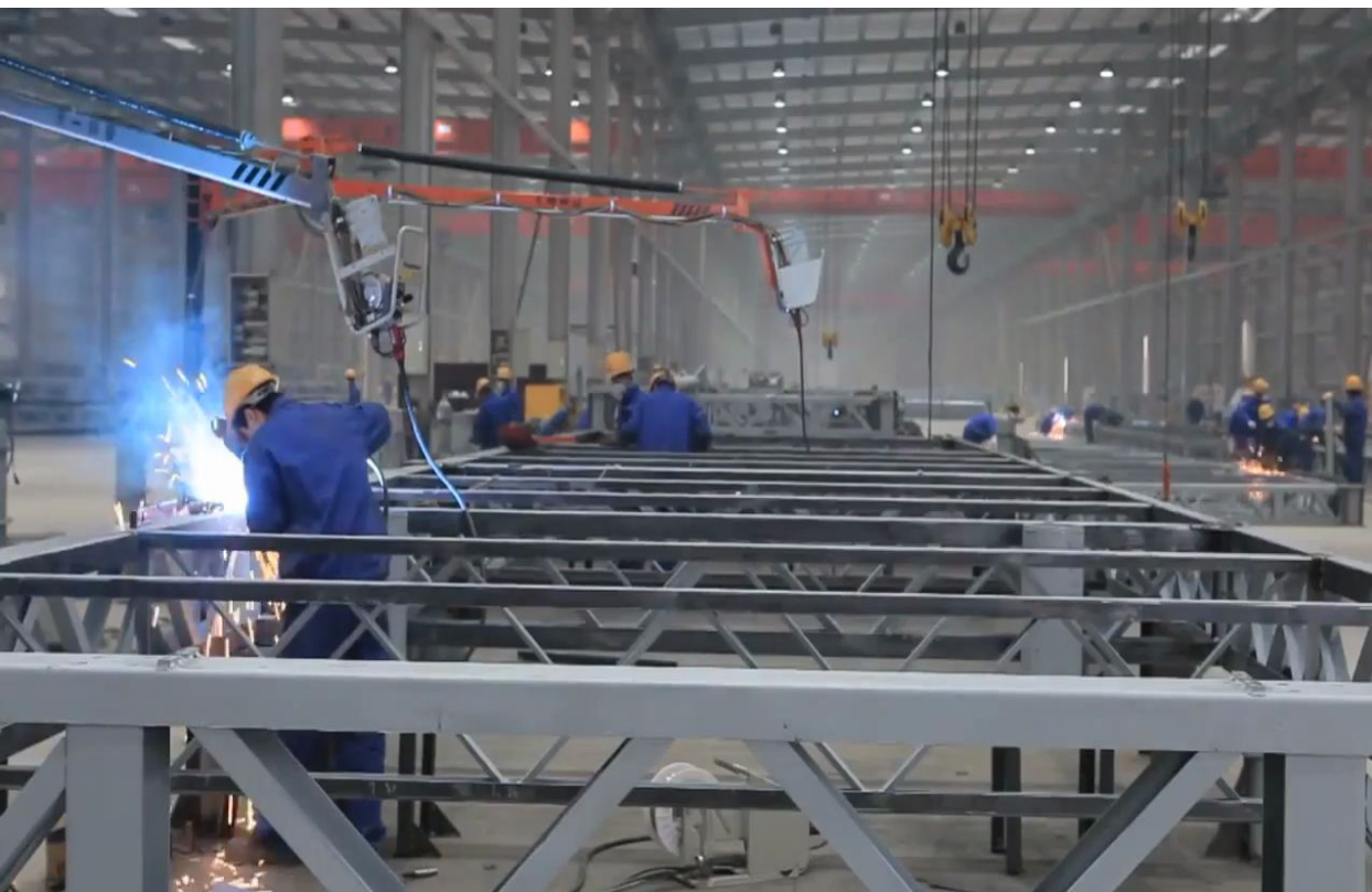
1. Сварка каркаса плиты перекрытия
