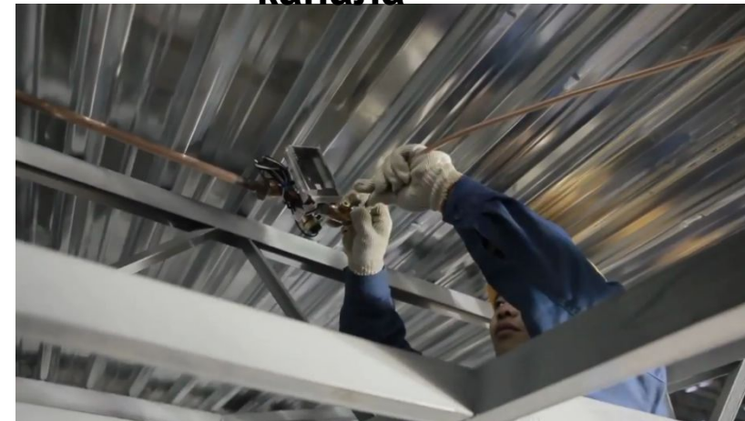
Монтаж водных коммуникаций
