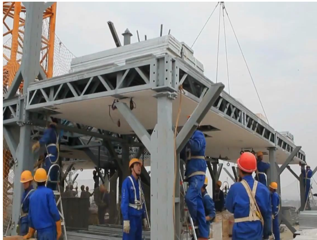
Установка плиты перекрытия на проектную отметку
