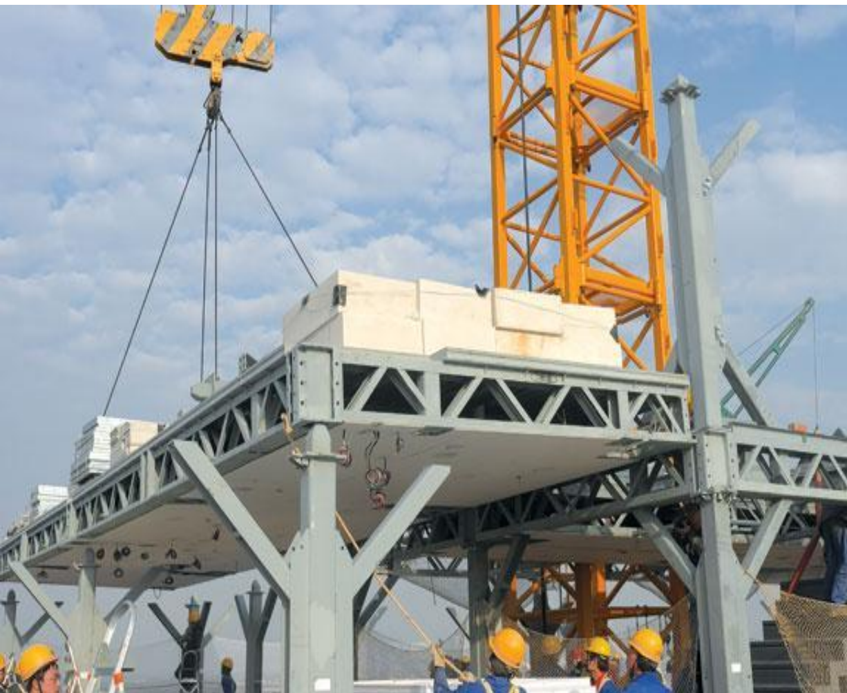
Установка плиты перекрытия на проектную отметку
