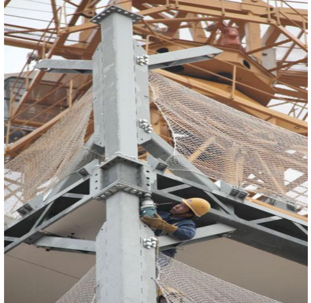
Монтаж вышележащей плиты перекрытия на втулку колонны
