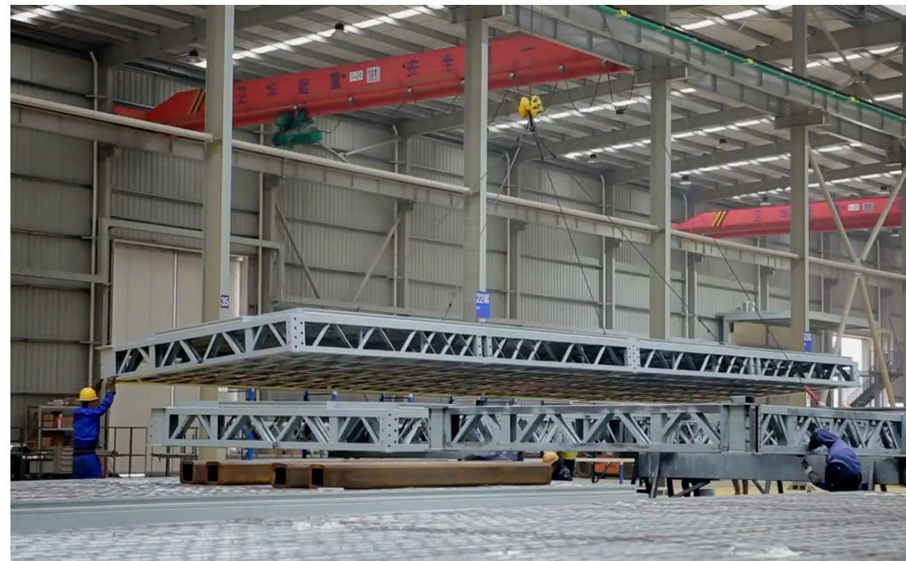
2. Перемещение каркаса далее по конвейеру
