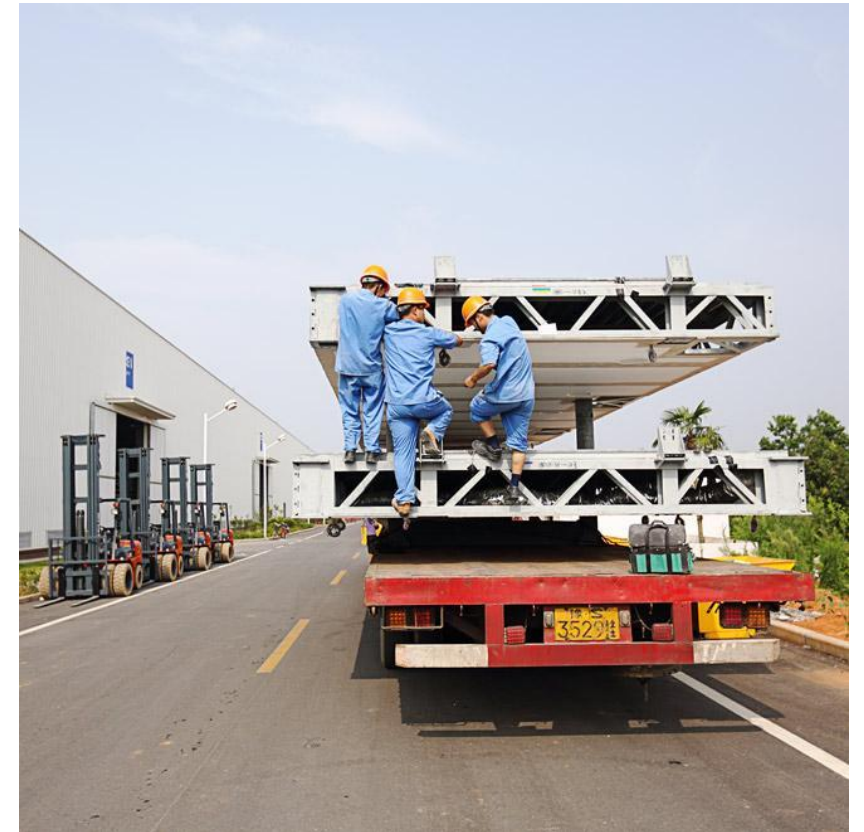
Доставка плит перекрытия на строительную площадку
