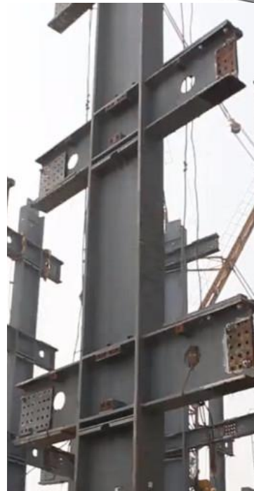
Колонна с вертикальными опорами
