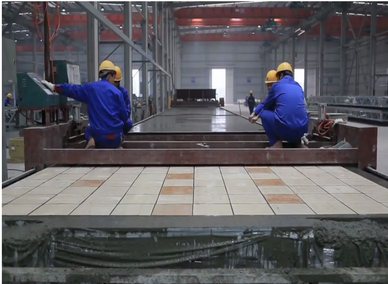
Укладка плиточного покрытия пола
