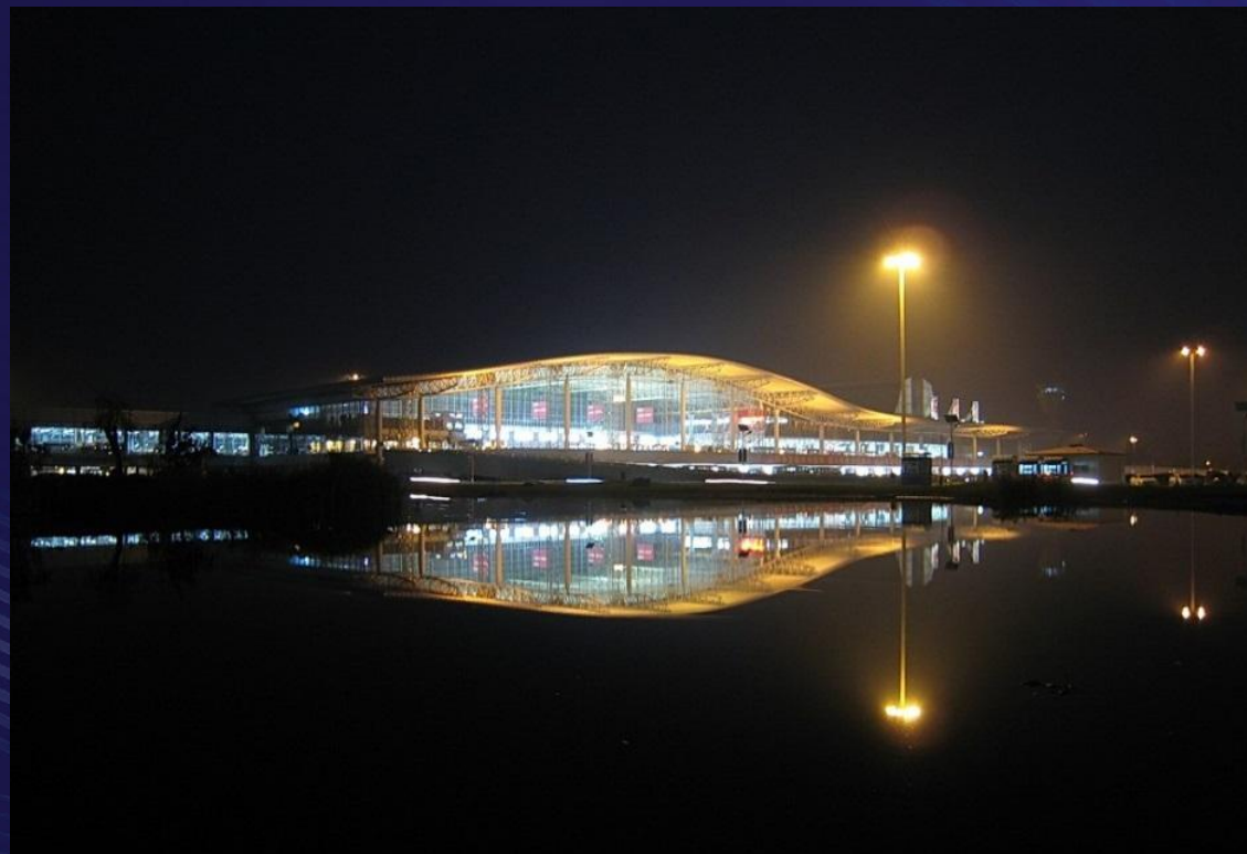
石家庄正定国际机场亮化照明
