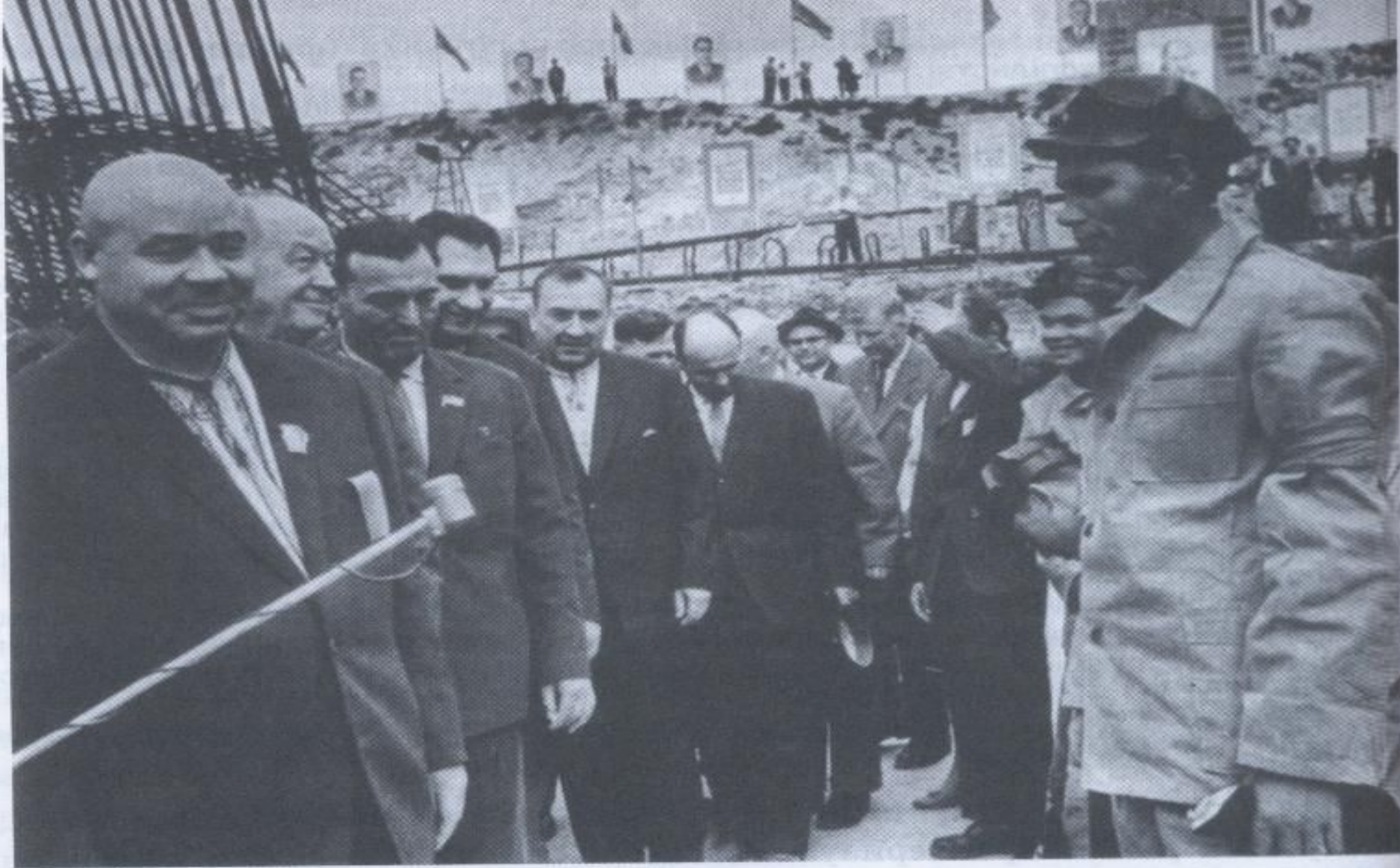
П. Шелест ( першій ліворуч) на будівництві Трипільської ДРЕС. 1964 р.
