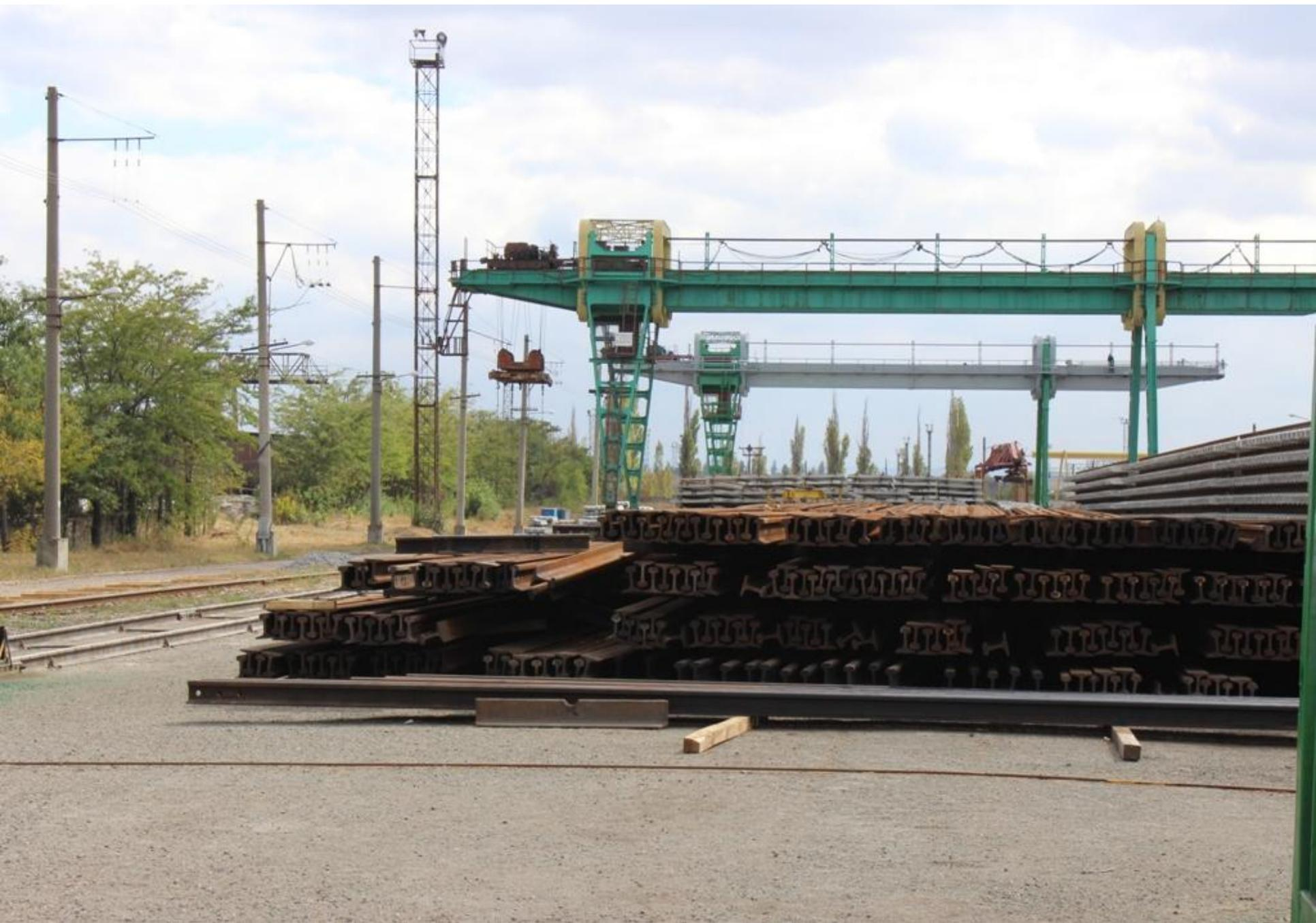
Базы для сборки звеньев пути (звеносборочные базы) располагают вблизи от мест примыкания новостроящихся линий к существующим железным дорогам или судоходным водным путям. При строительстве вторых путей и развитии станций базы располагают на отдельных пунктах с таким расчетом, чтобы использовать имеющиеся станционные пути и максимально сократить дальность транспортирования рельсовых звеньев.
