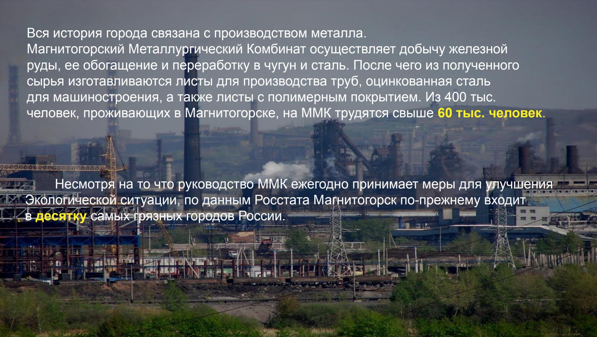
Вся история города связана с производством металла. Магнитогорский Metallургический Комбинат осуществляет добычу железной руды, ее обогащение и переработку в чугун и сталь. После чего из полученного сырья изготавливаются листы для производства труб, оцинкованная сталь для машиностроения, а также листы с полимерным покрытием. Из 400 тыс. человек, проживающих в Магнитогорске, на ММК трудятся свыше **60 тыс. человек.**
