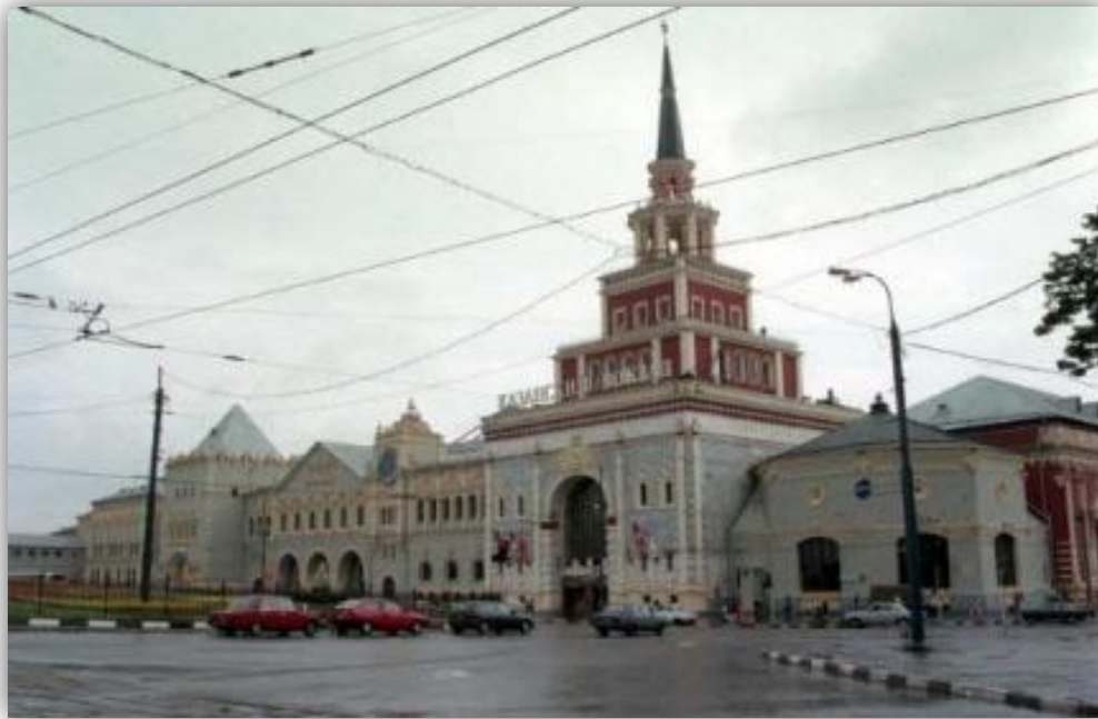
Щусев А.В. Здание Казанского вокзала в Москве
