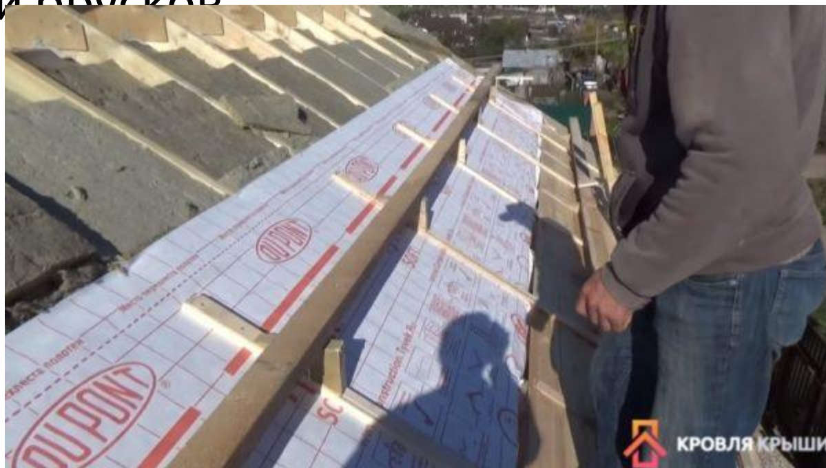
Фиксация гидроизоляционного материала
