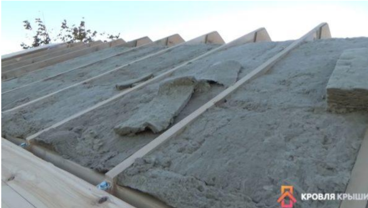
Утепление крыши минеральной ватой
