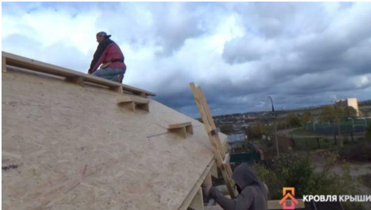
Обшивка кровельного пирога плитами OSB
