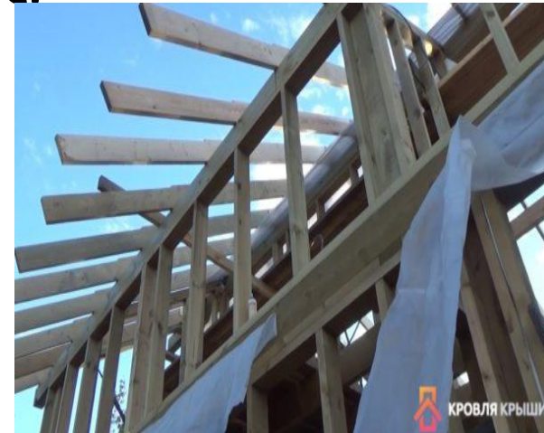
Стропильная система
