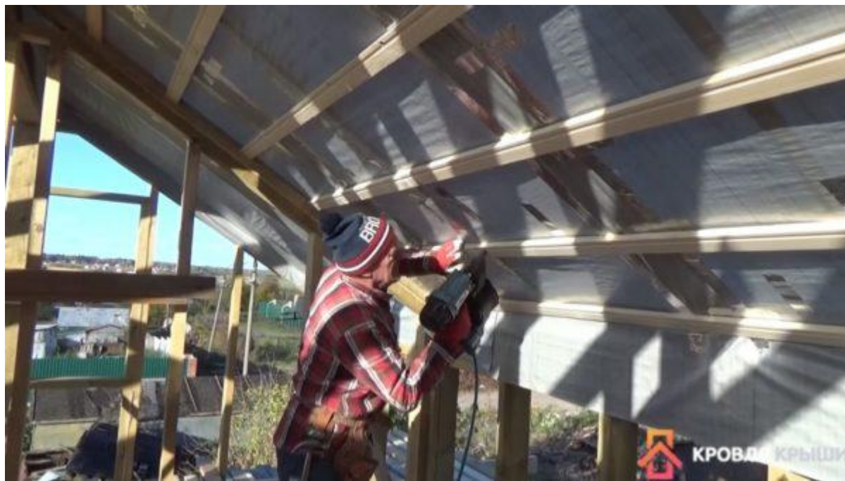
Крепление материала к стропильной системе
