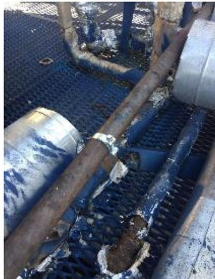
Ремонт сквозной коррозии с помощью хомута (л. 43/13)
