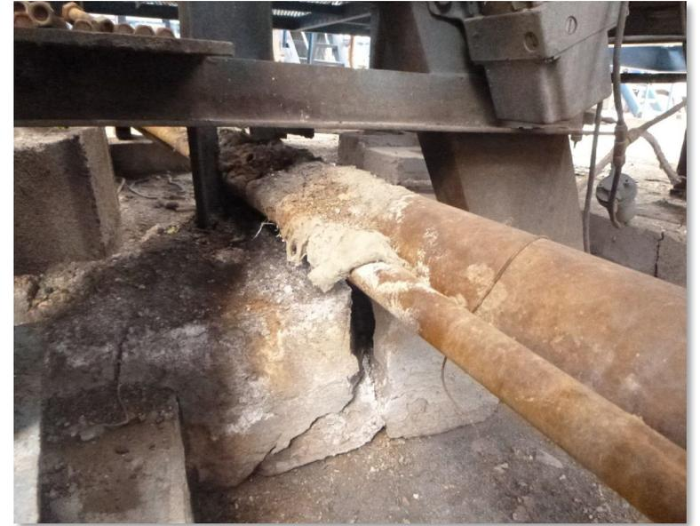
**Разрушение фундамента опоры (л. 10)**
