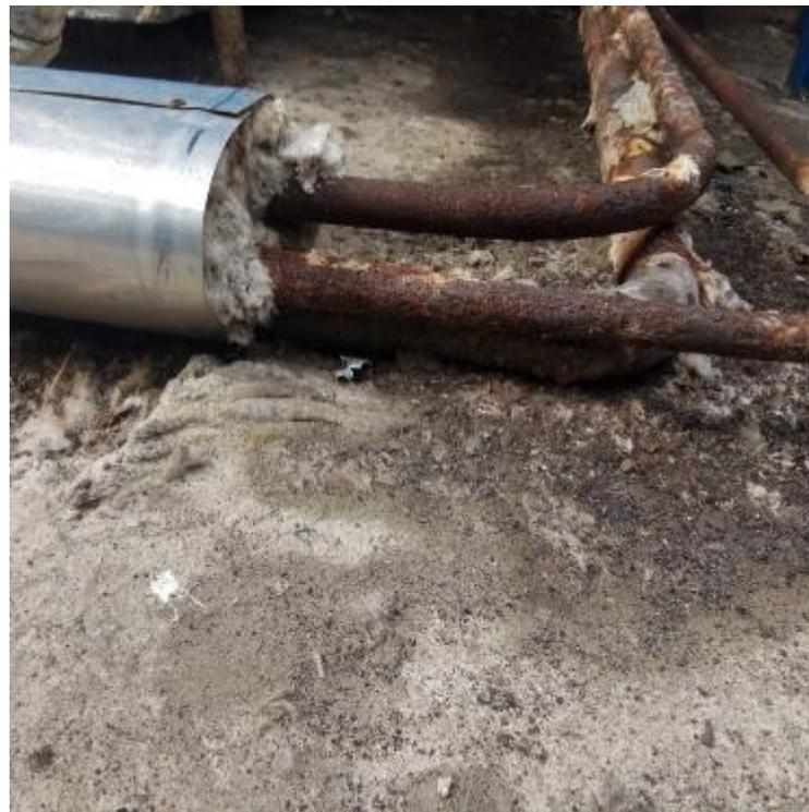
**Отсутствует опора, трубопровод
