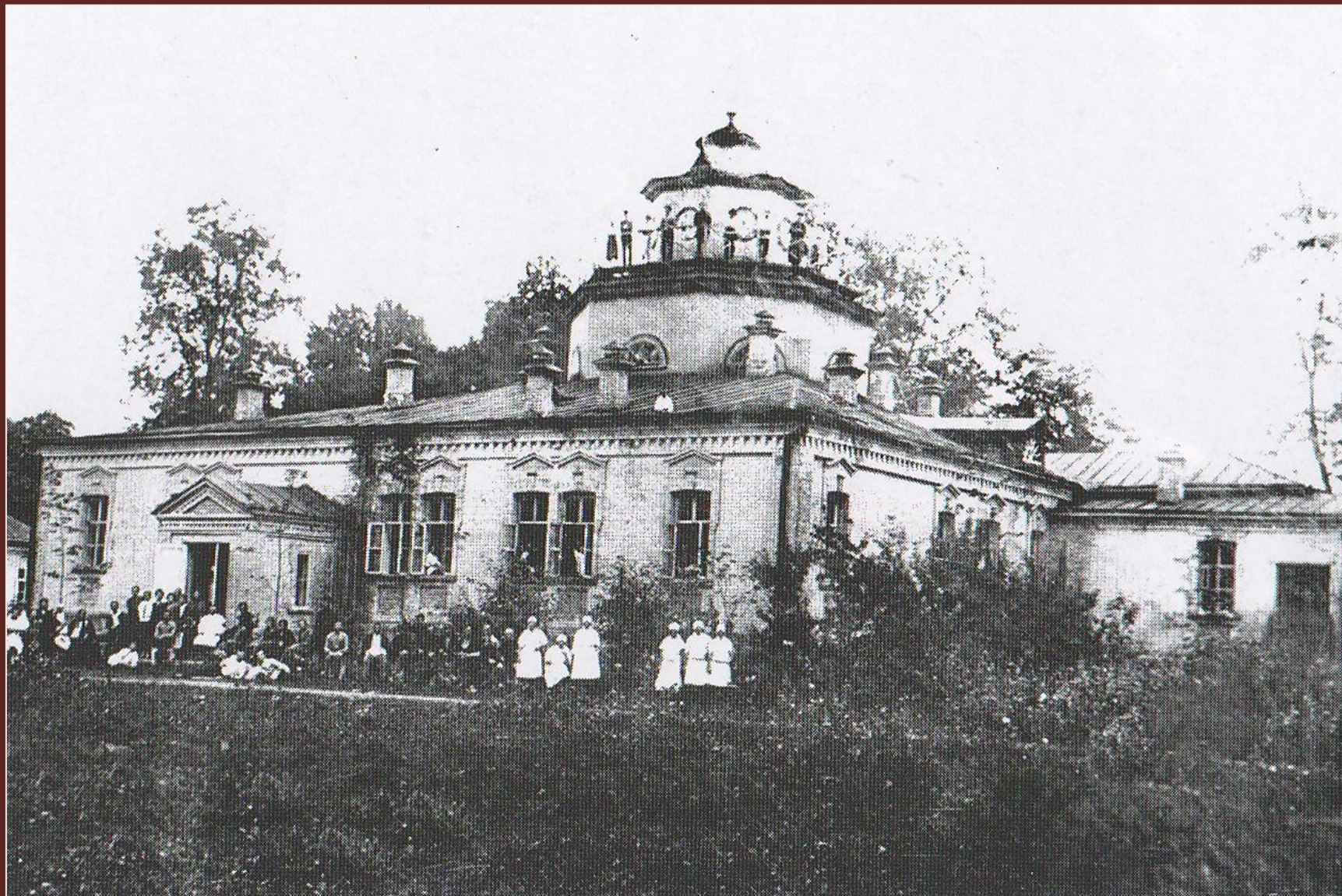
Северо-западная часть усадебного дома после обкладки кирпичом. Фото 30-х гг. XX в.
