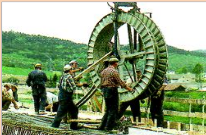
Укладка напрягающих элементов
