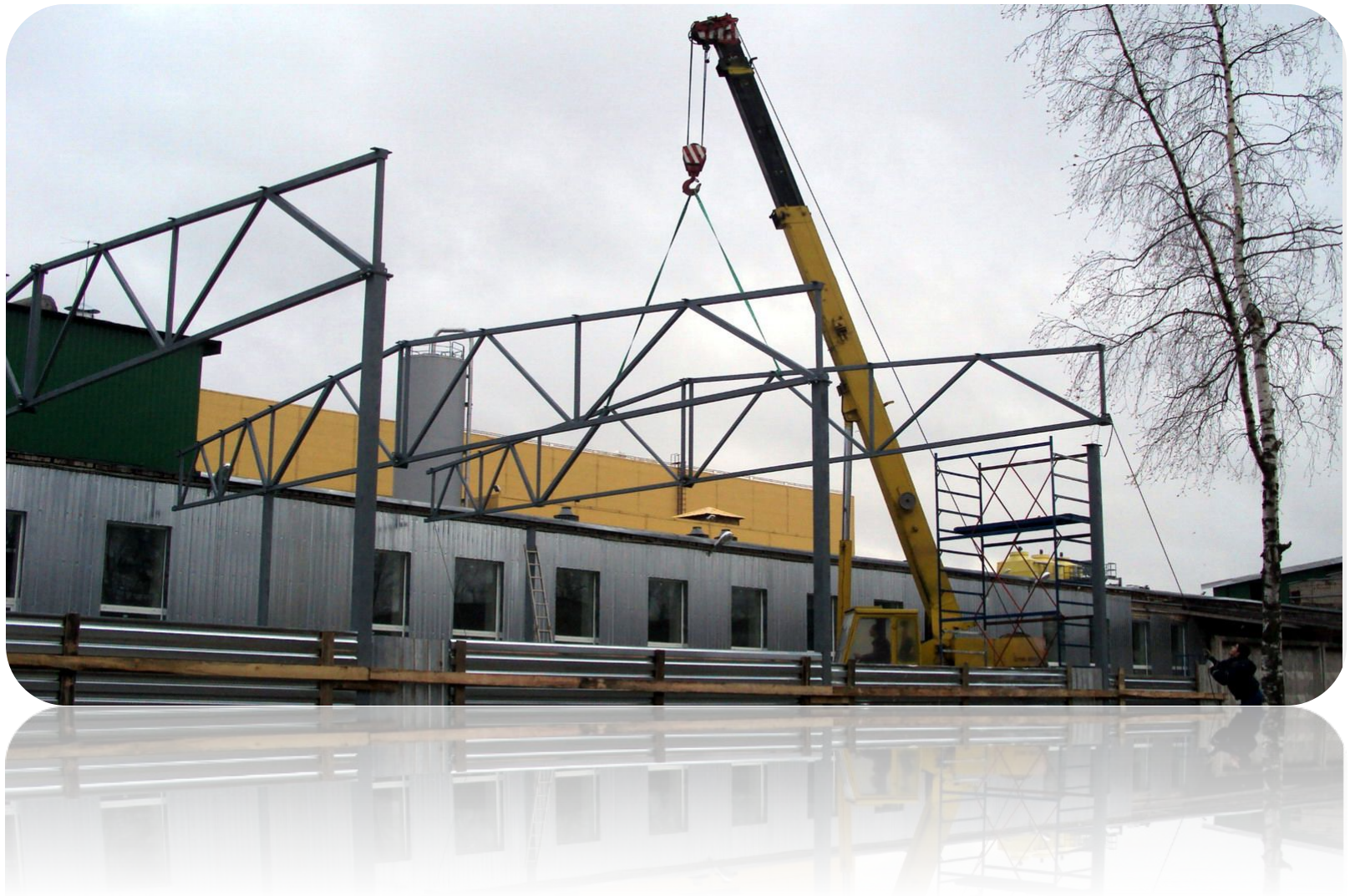
Рисунок 3 – Металлические плоские фермы ангара
