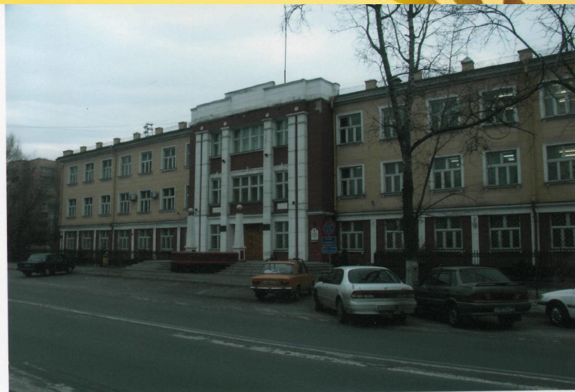
Здание "Хакзолото". Ныне здание МВД Республики Хакасия.
