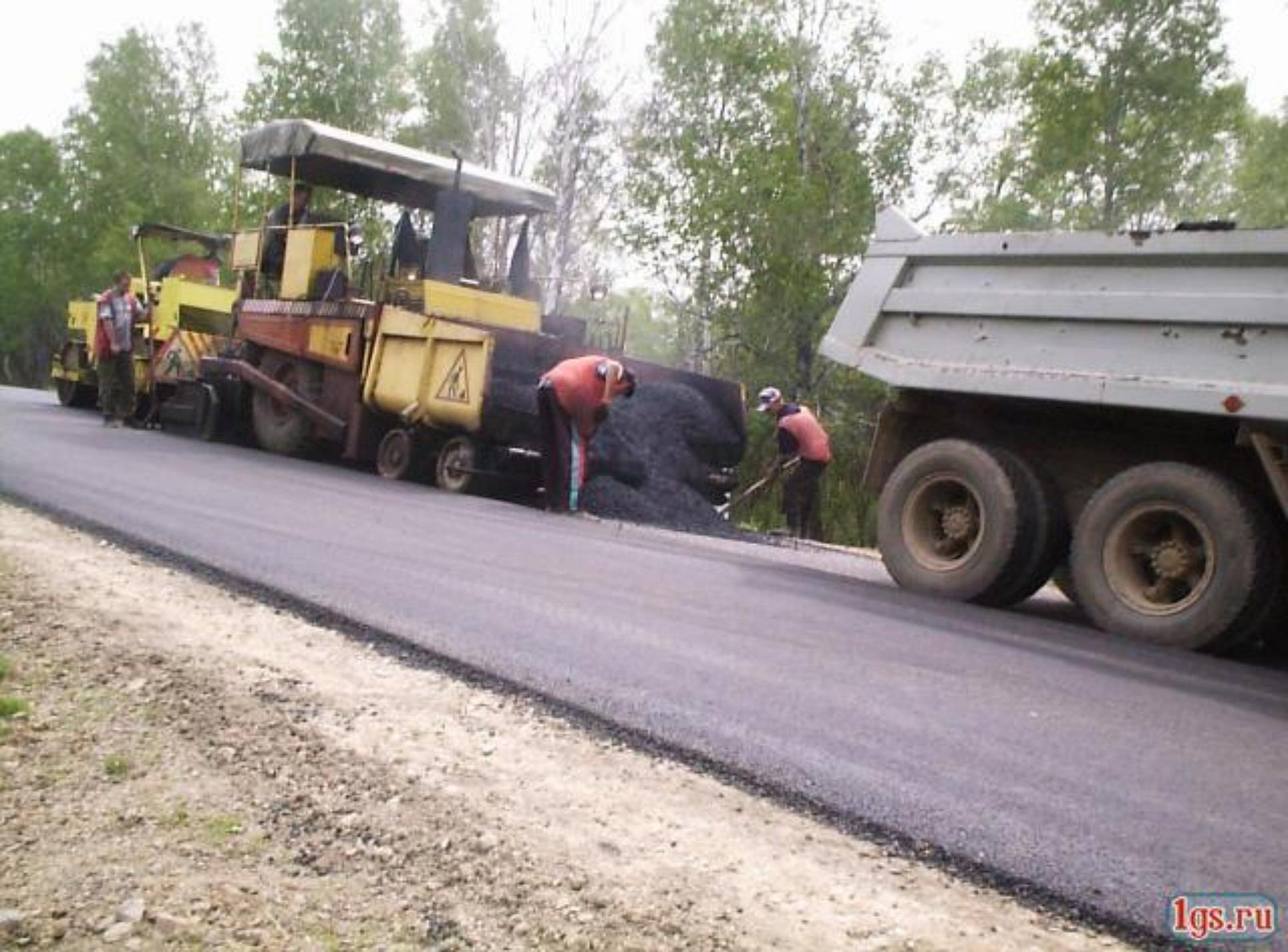
**Обочины дороги** служат для создания упора проезжей части при строительстве дороги, предохранения краев покрытия от обламывания, разъезда и остановок автомобилей при недостаточной ширине проезжей части.
