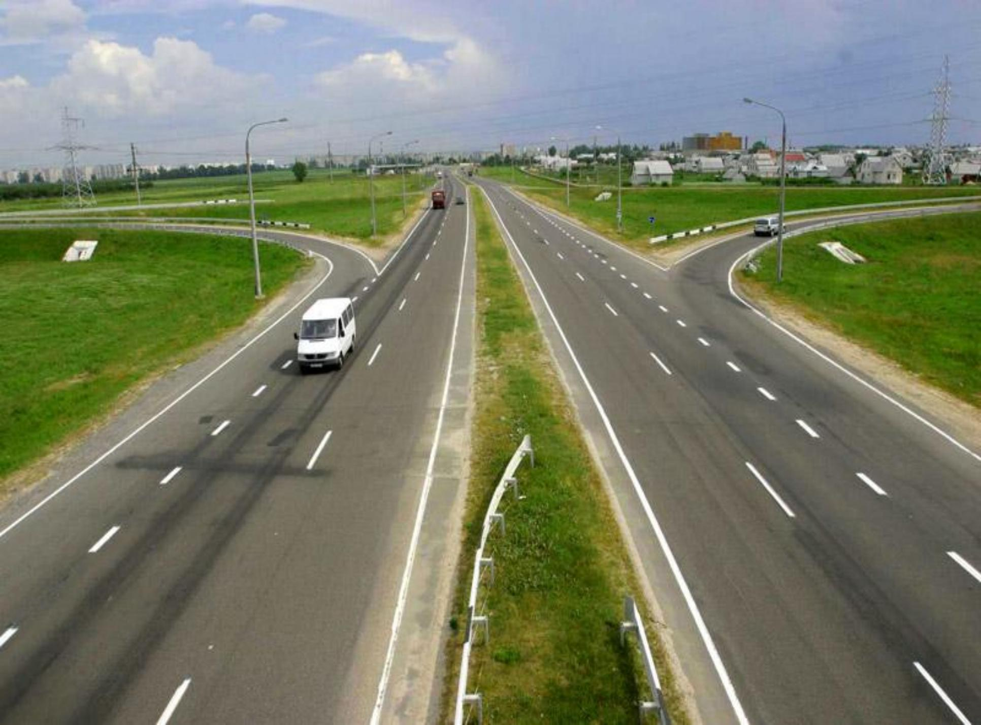
*Проезжая часть дороги представляет собой прочную и плотную поверхность, предназначенную для движения транспорта. Проезжая часть, как правило, располагается симметрично относительно оси земляного полотна.*
