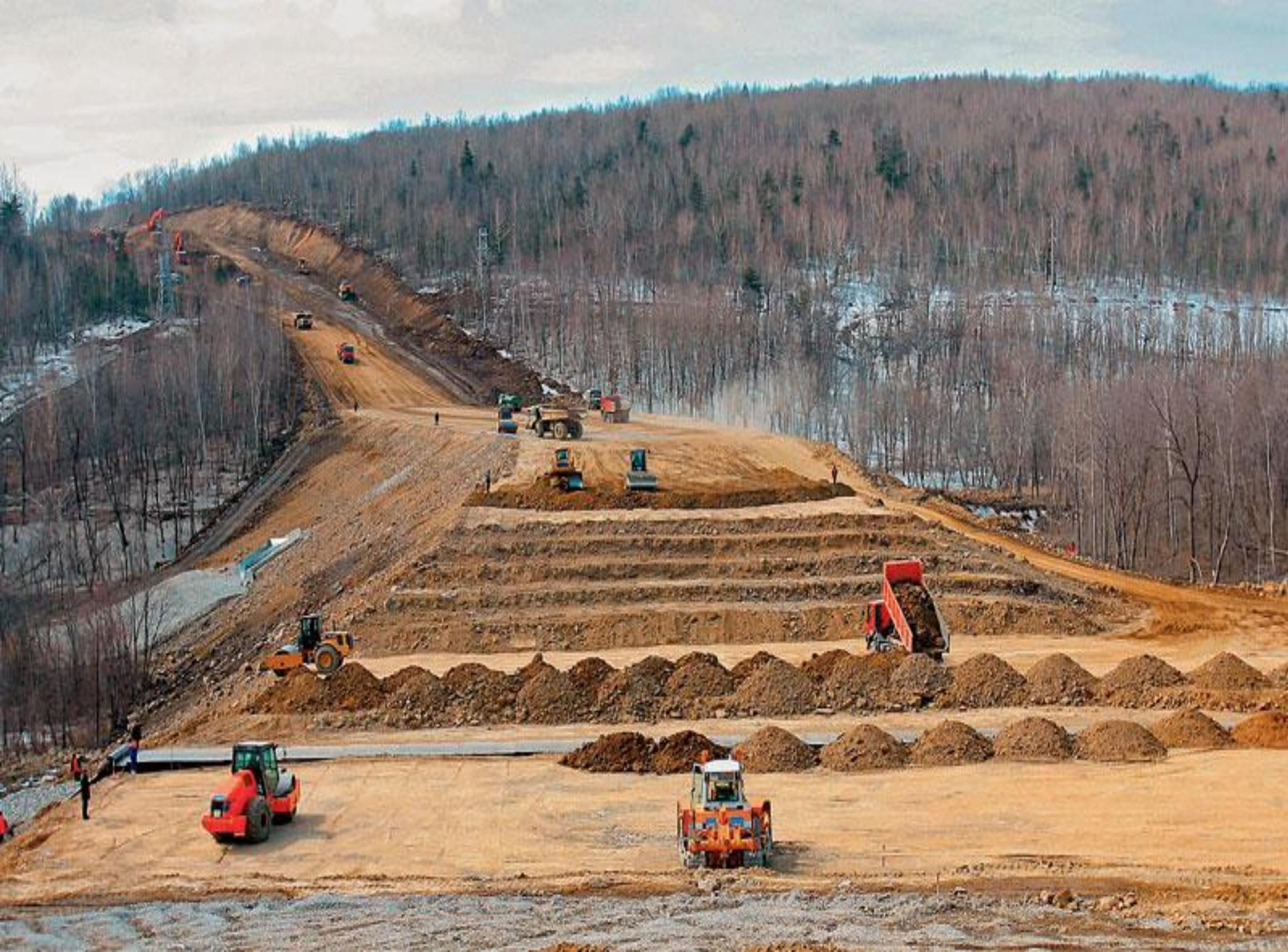
Боковые поверхности земляного полотна, представляющие собой наклонные плоскости, называют **откосами**. Линию пересечения поверхности откоса с поверхностью земли для насыпи называют *подошвой откоса*, а для выемки - *верхней бровкой откоса*.
