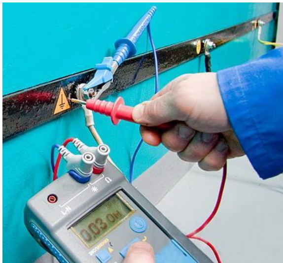
проверка сопротивления заземления;
