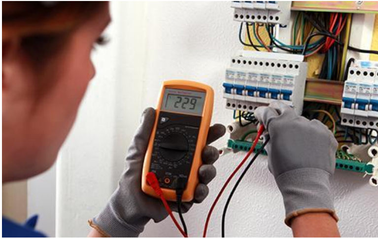
проверка сопротивления изоляционного слоя;
