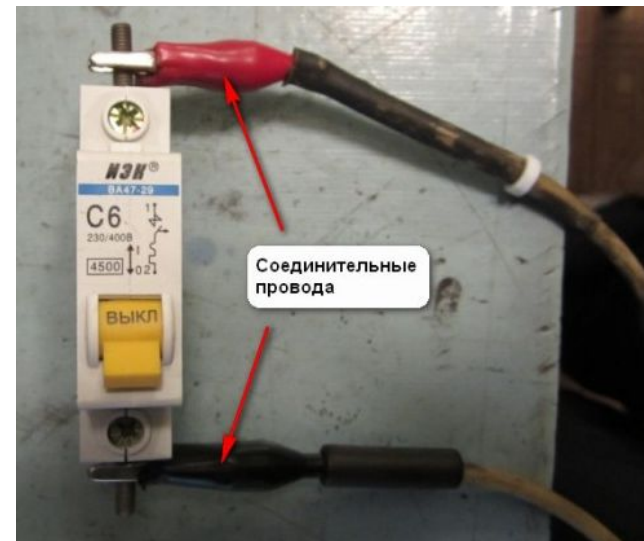
прогрузка первичным током автоматических выключателей.
