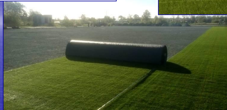
Укладка искусственного покрытия футбольного поля на стадионе по ул. Строительной г. Беломорск
