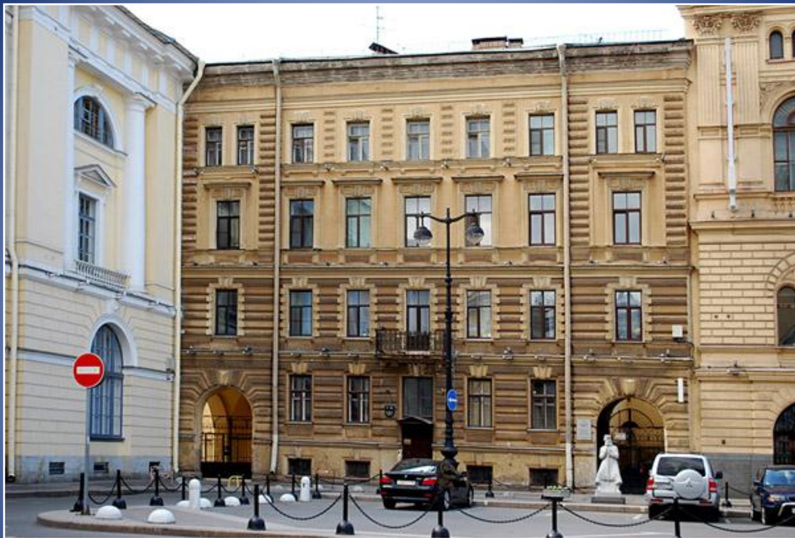
Здание Русского музыкального общества в Санкт-Петербурге
