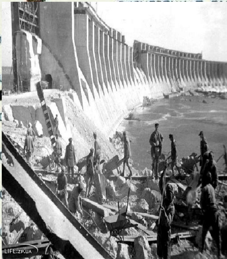
Строительство Днепровской ГЭС
