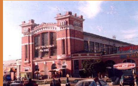
Здание крытого Благовещенского рынка по ул. Энгельса 33, архитектор И.И. Загоскин, 1914 г.
