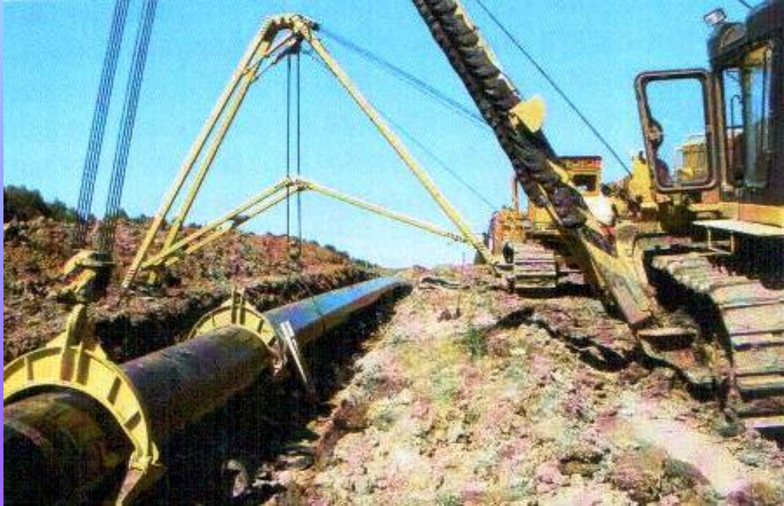
Рисунок 8 – Капитальный ремонт газонефтепровода с подъемом в траншее с применением стрелы опоры
