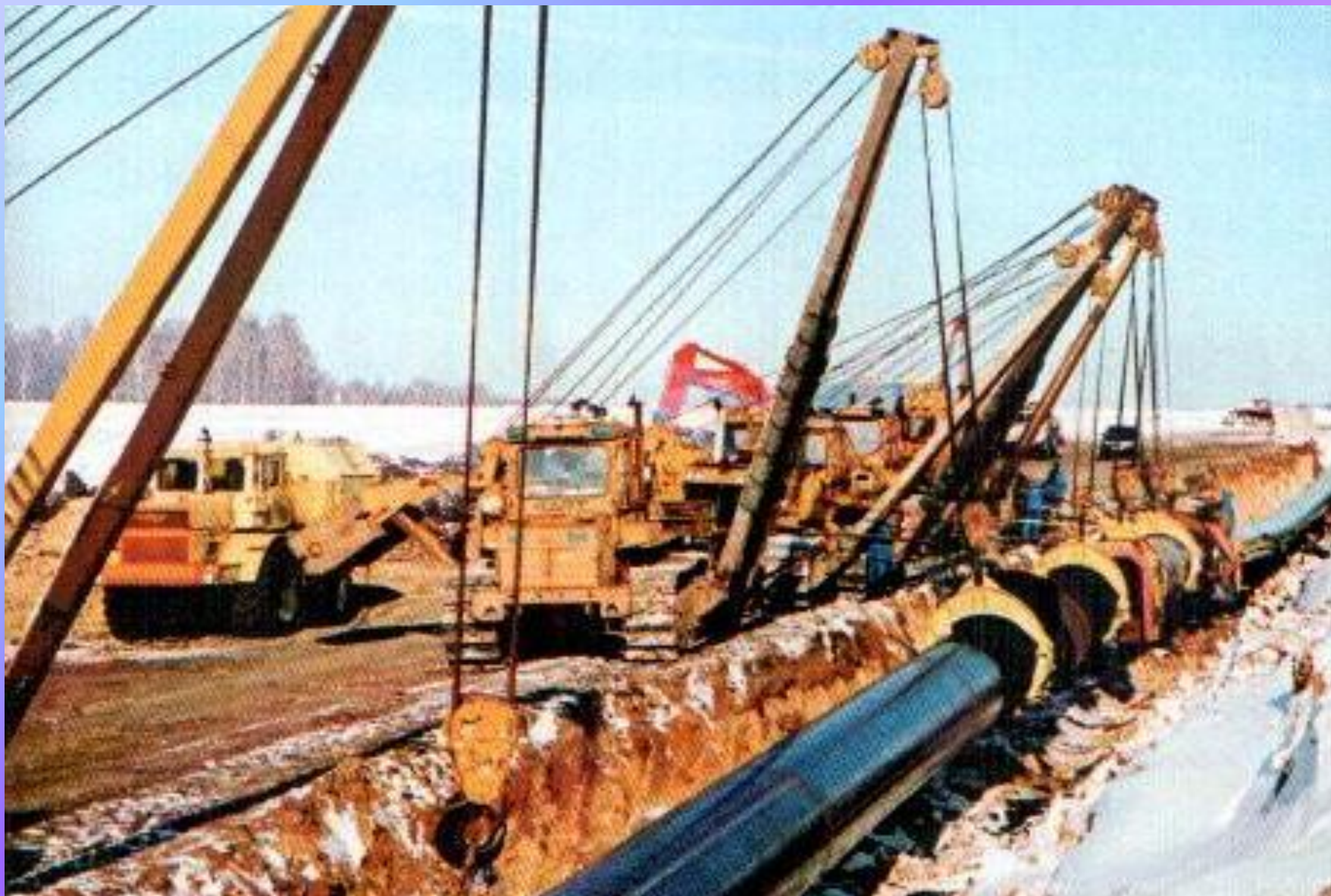
Рисунок 1.1 – нанесение защитного покрытия при капитальном ремонте в траншее
