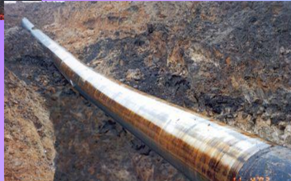
Рисунок 3 – Капитальный ремонт газонефтепровода в траншее без подъема с подкопкой под трубу
