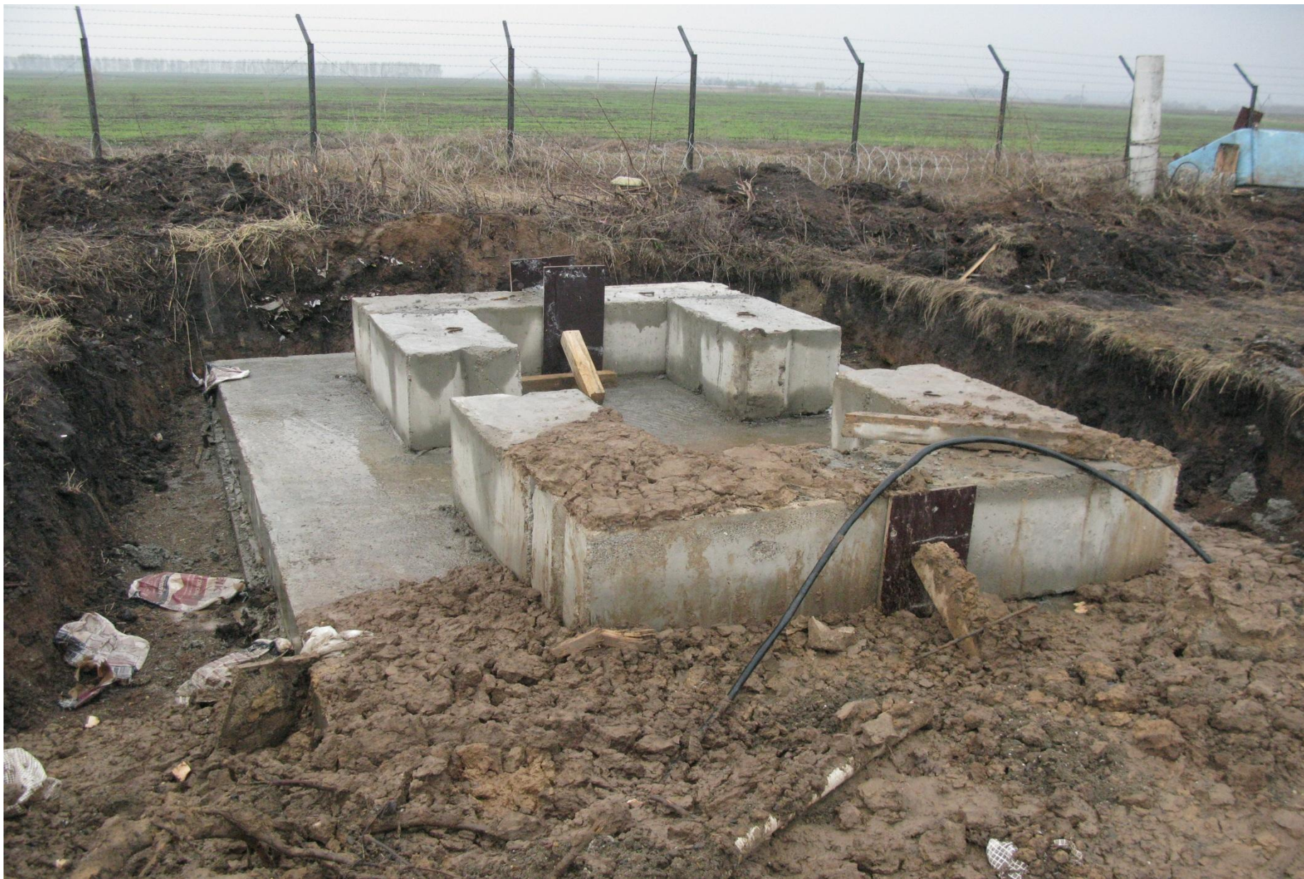
Строительство АРЛК «ЛИРА-А10»
