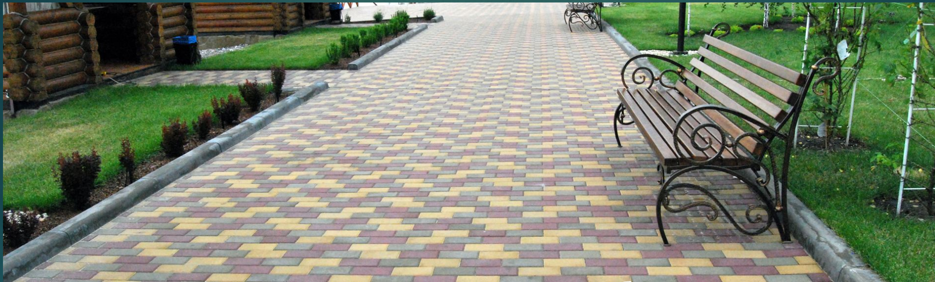
Дорожно-тропиночное покрытие - брусчатка
