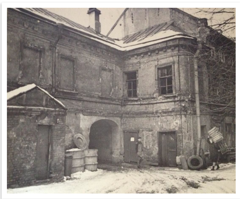
Ветхое здание на углу ул. Садовая и Лермонтовского пр. до реконструкции квартала
