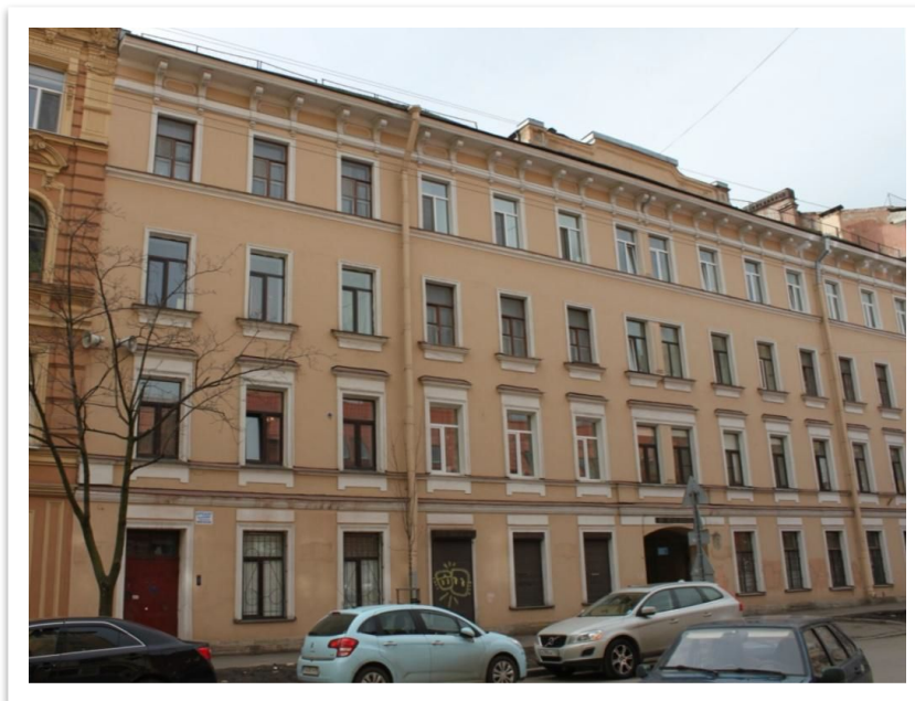
Здание №13 по пер. Макаренко после реконструкции
