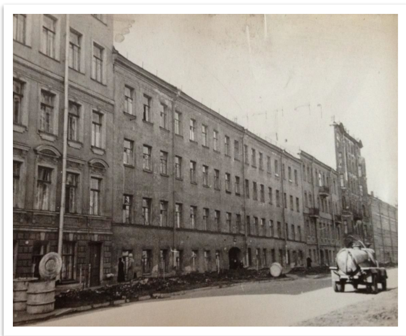
Здание №9 по пер. Макаренко до реконструкции
