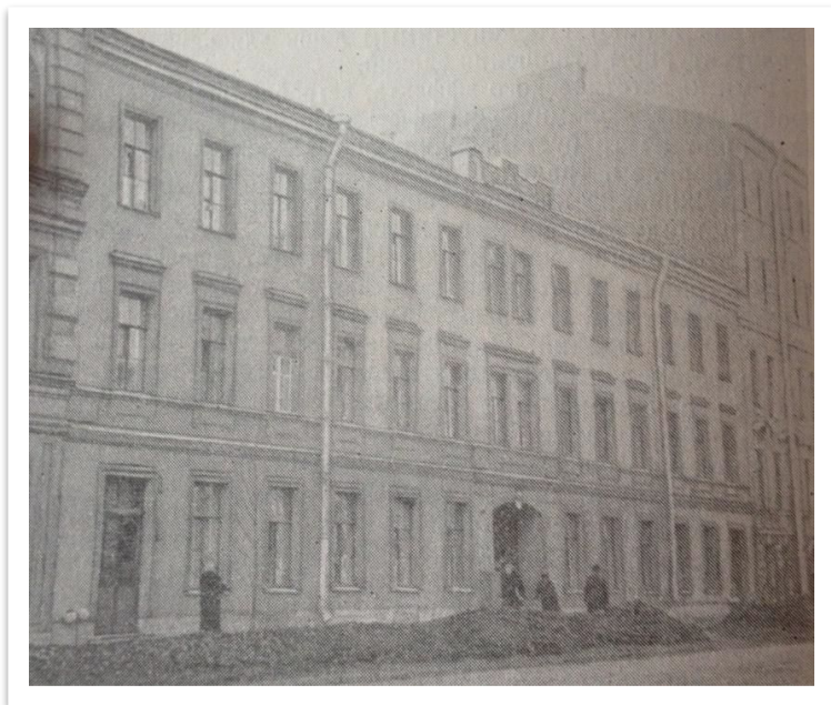
Здание №13 по пер. Макаренко до реконструкции
