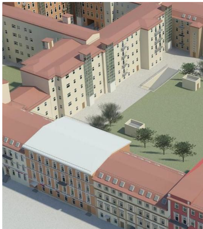
Здания после установки лифтов
