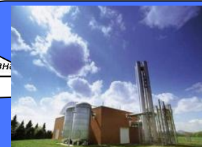
Когенерационная станция W=6,4 МВт
