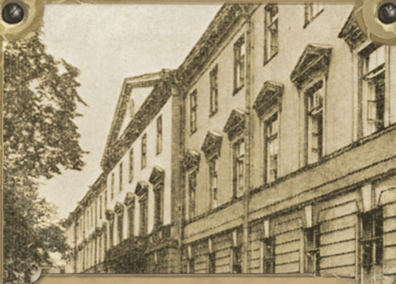
Бывшее здание Школы гвардейских подпрапорщиков и кавалерийских юнкеров
