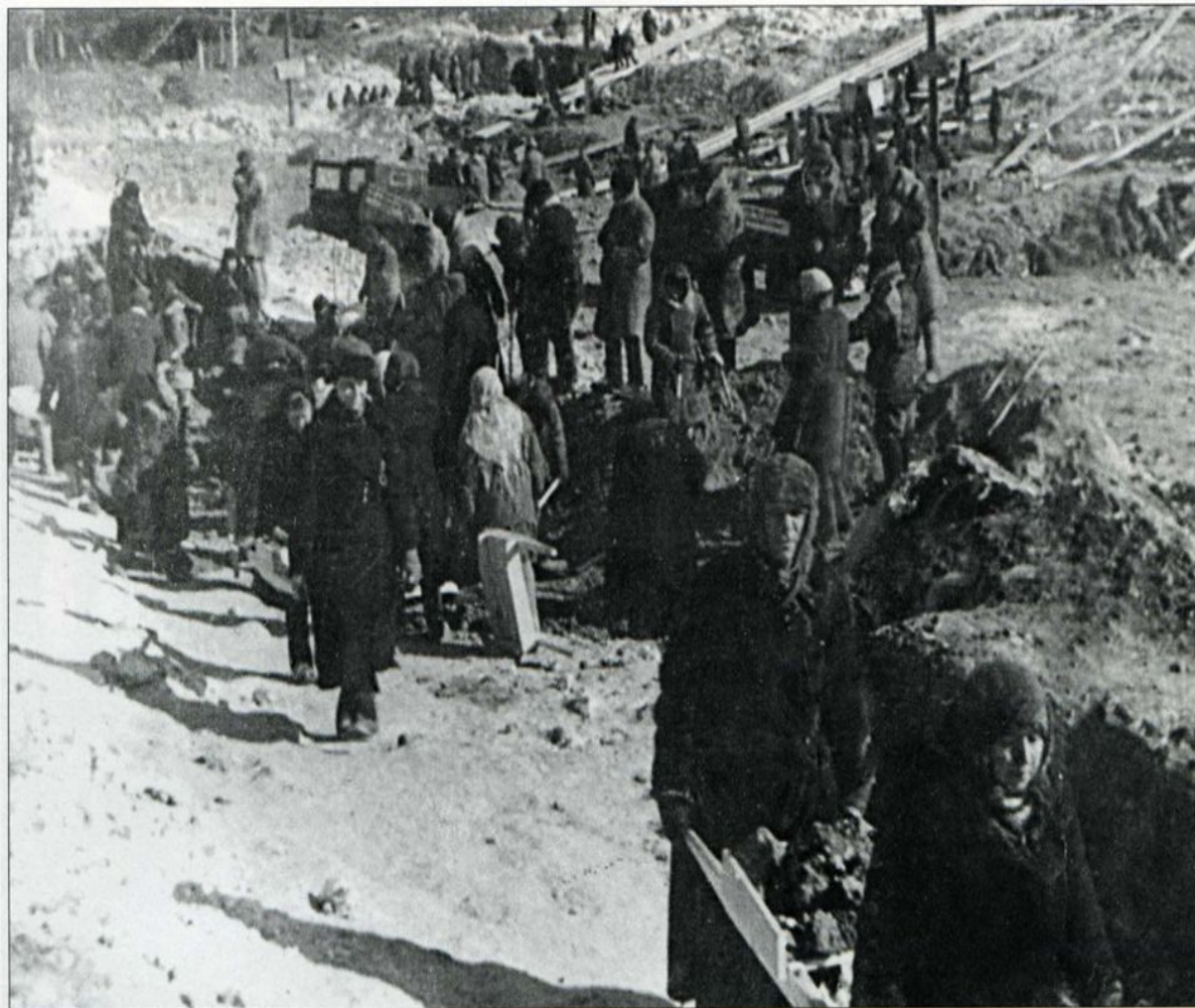
Строительство тракторного завода. Рубцовск. 1942 г. АГКМ
