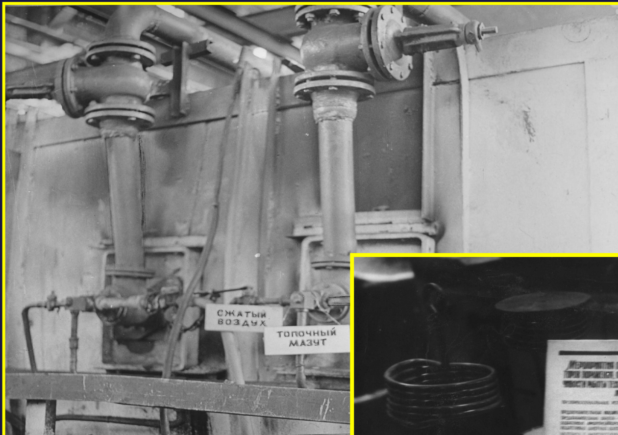
Подготовка котельной к работе на резервных видах топлива
