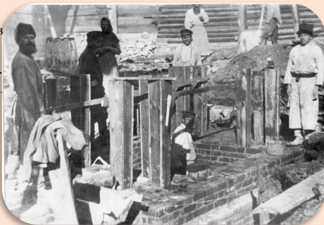
Строительство Абаканского железоделательного завода.
