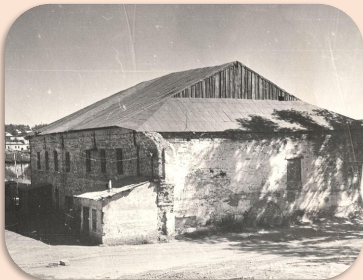
Павловский сереброплавильный завод, производственный корпус, вид с юга. Л. Е. Майстров, 1973
