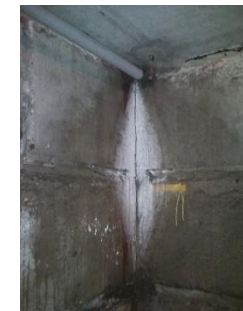
Промерзшие стены подвала
