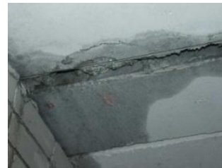
Протечки (конденсат) на потолке верхнего этажа
