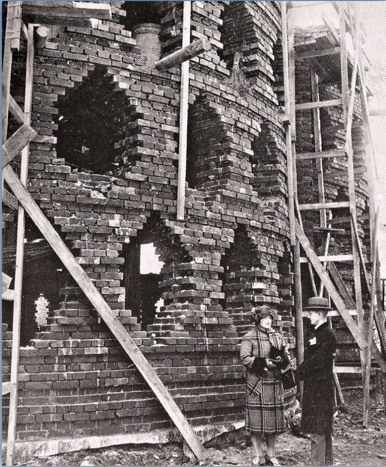
Каркас дома в процессе строительства, 1927—1929 годы
