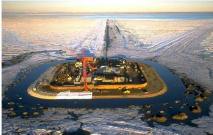
Гравийный остров месторождения North Star в процессе строительства (слева) и после
