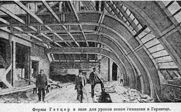
Фермы Гетцер в зале для уроков пения гимназии в Герлицце.
