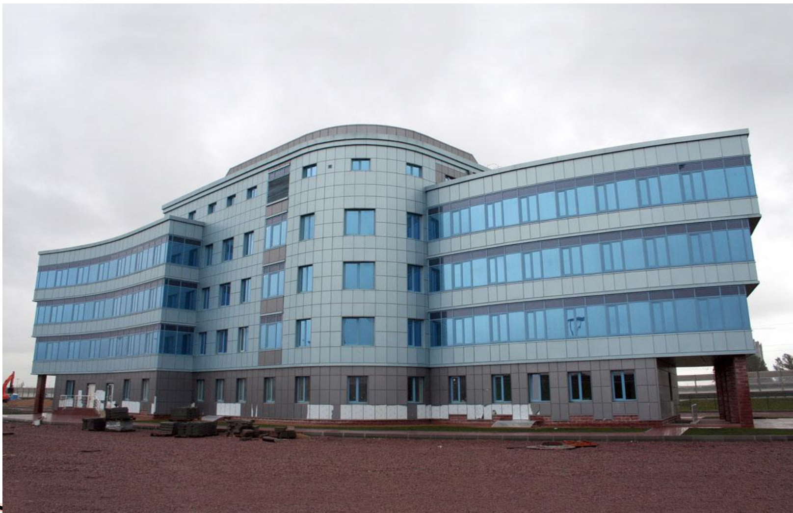
Здание Центрального пункта управления КАД
